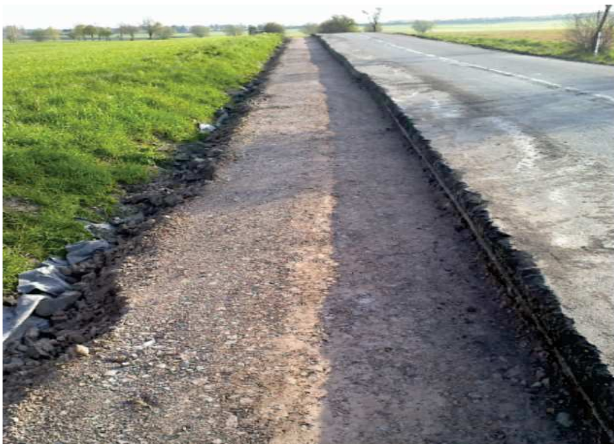
Urovnaná a zhutněná zemí pláň. dole po položení asfaltového recyklátu před odfrézováním starých asfaltových vrstev
