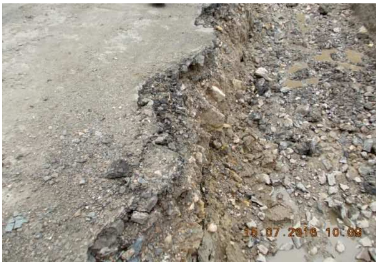
Rýha pro provedení rekonstrukce vozovky okrajů silnice bez zajištění odvodnění podloží, výskyt povrchové vody jak v podloží, tak propustné sanační vrstvě
