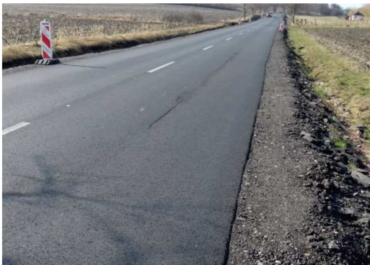
Položená ložní vrstva a dole i obrušná vrstva podélnou trhlinou
