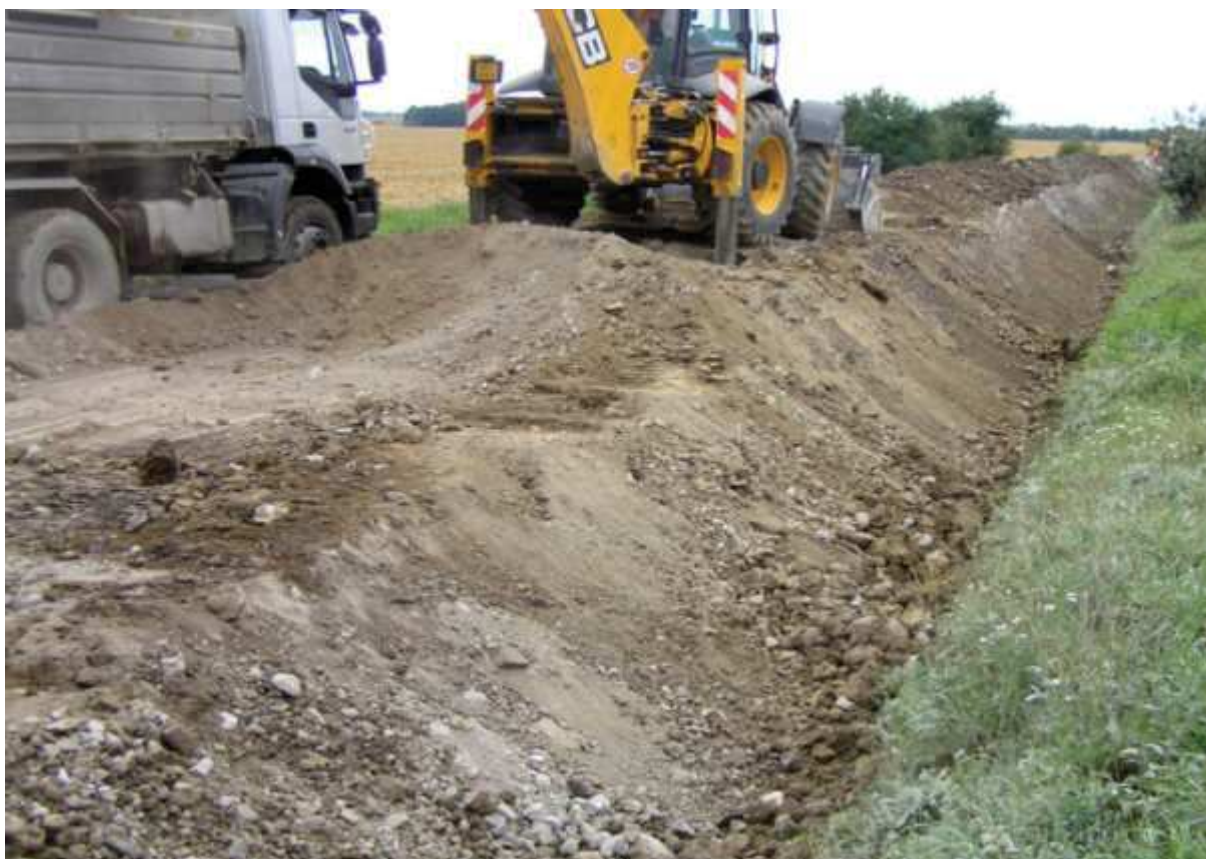
Úprava nevhodné zeminy na hrázce pojivem GEOSOL C50 a její zabudování do rýhy
