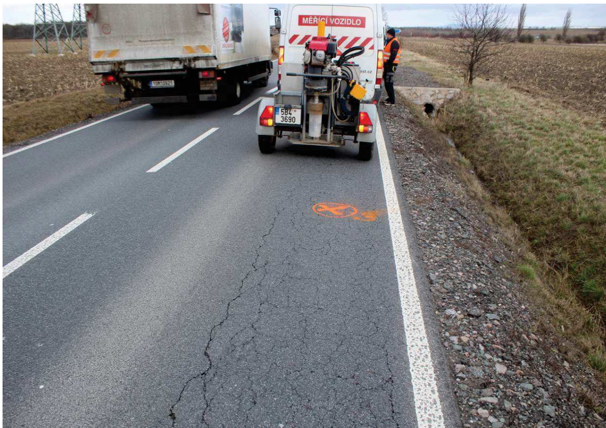
Obrázek 20 – Výrazná lokální porucha se síťovými trhlinami poklesem vozovky a deformací násypového tělesa včetně příkopu, km 9,538
