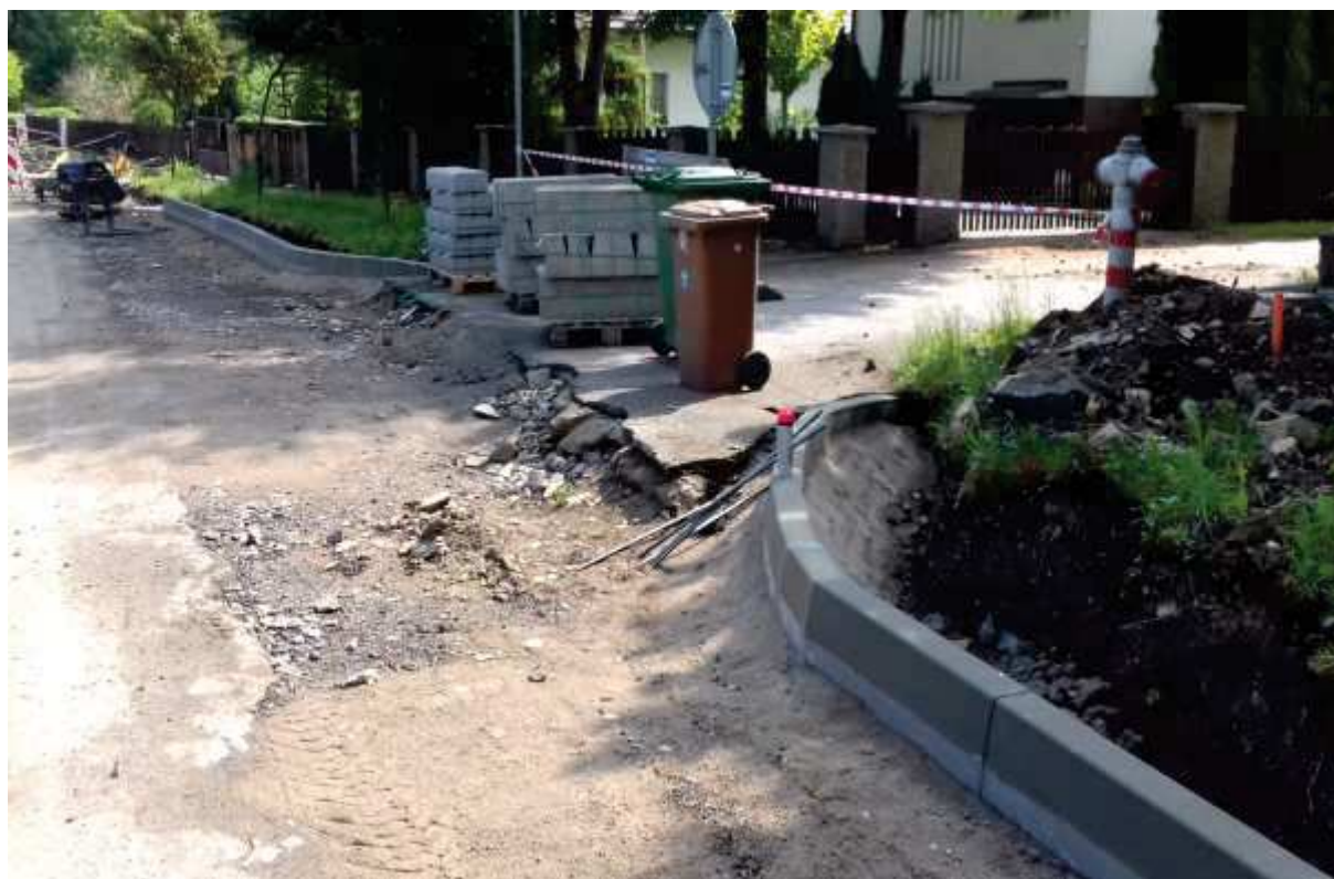
Příprava pro provedení podkladu recyklací, dole křižovatka s II/299, provádění podkladu z cementem stmeleného kameniva před pokládkou asfaltových vrstev
