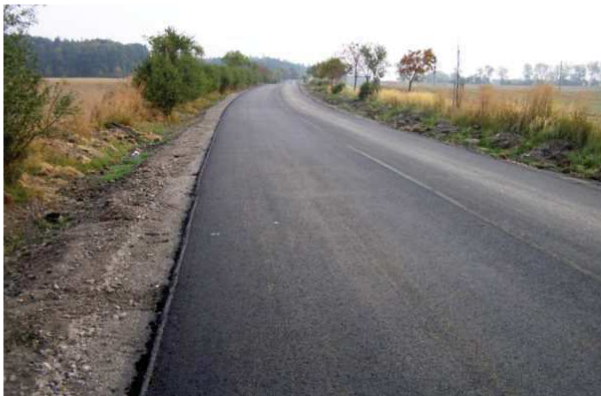
Dokončená vozovka před provedením nestmelené krajnice a příkopů
