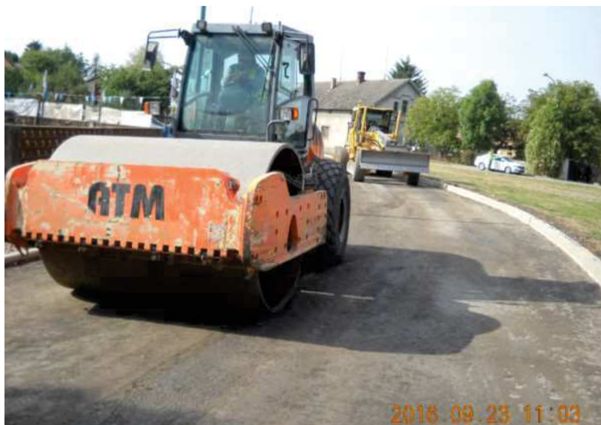
Provedená recyklace podkladu a dokončovací práce
