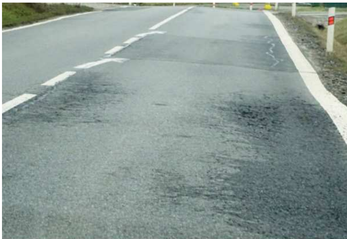
Poruchy a opravy poruch, za obcí Černilov, začátek úseku 3
