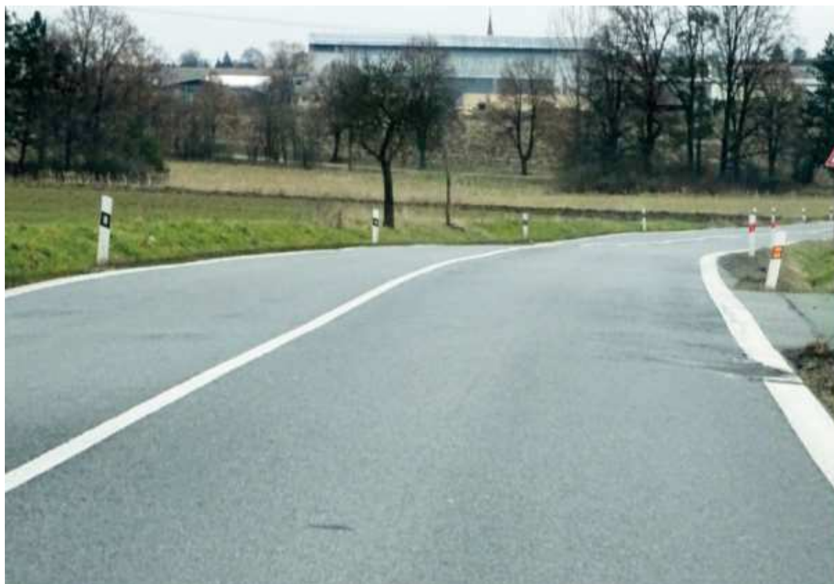
Koroze povrchu a nerovnosti vozovky s trhlinami konec úseku 1, následuje oprava z rok 2011
