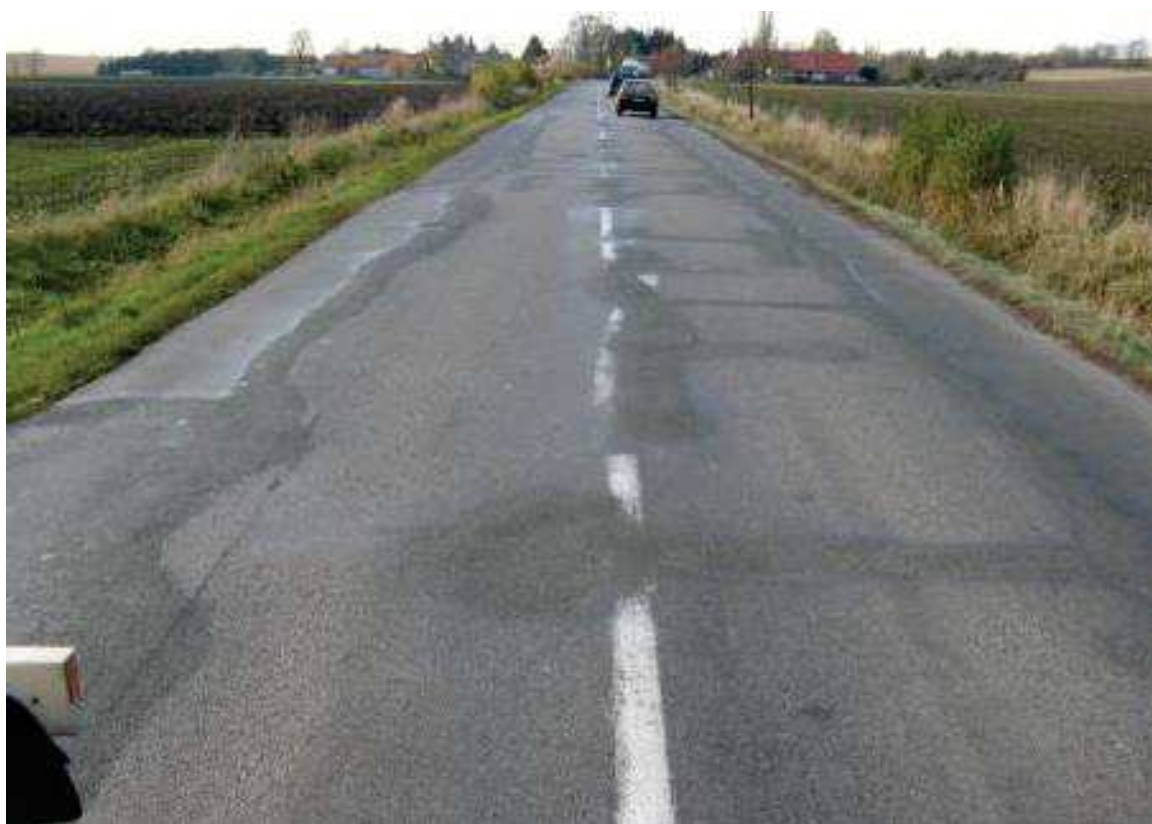
Fotografie 6, km 12,060 – Vysprávka asfaltovou směsí, opět se vyskytující síťové trhliny (prolomení vozovky).
