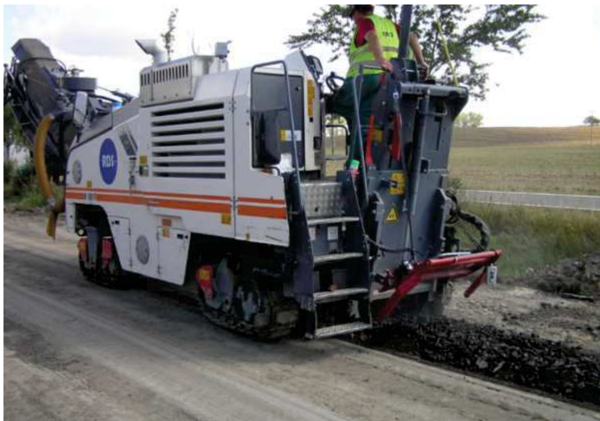
Rozfrézování asfaltových vrstev
