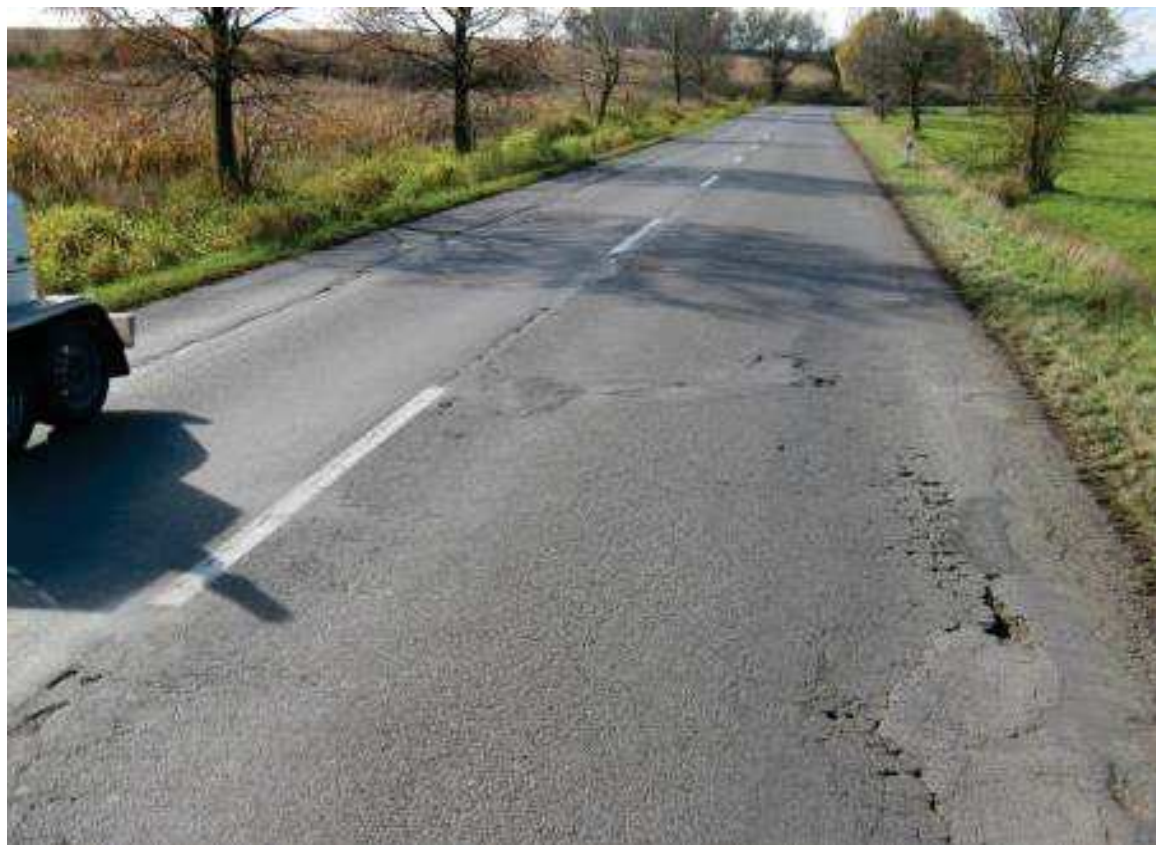
Fotografie 4, km 9,205 - Síťové trhliny a vysprávký asfaltovou směsí podél okrajů vozovky bez odvodňovacích příkopů.
