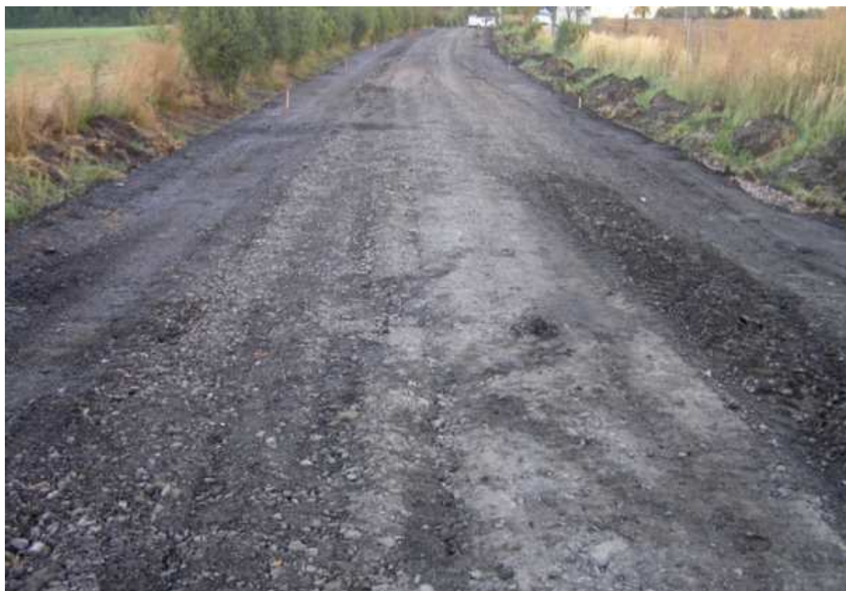
Příprava pro recyklaci podkladu rozfrézováním asfaltových vrstev a přidáním recyklátu nad rýhy v okraji vozovky
