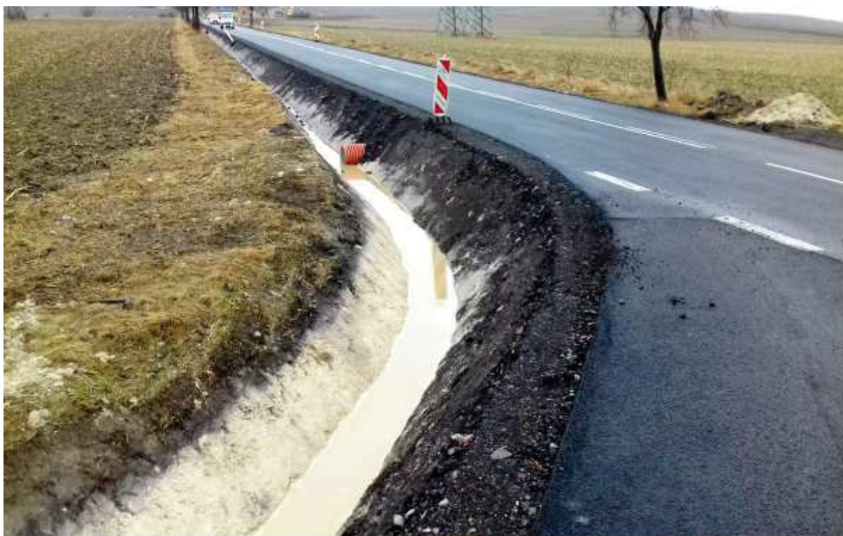
Pohled na výtok z propustku, příkop zaplněn stojící vodou, dole protažení příkopu v odbočce na obec Výrava s klesající hladinou vody (vadné spádování příkopu).
