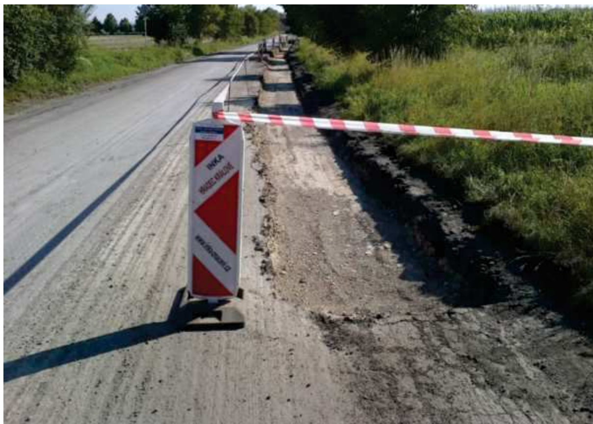
Rýha pro provedení rekonstrukce vozovky okrajů silnice bez zajištění odvodnění podloží
