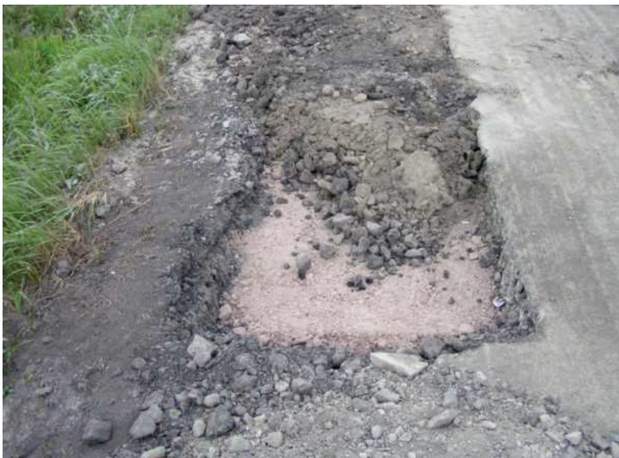
Výstavba vozovky v rýze v okraji silnice bez zajištění odvodnění, dole poslední vrstva v rýze neznámého původu
