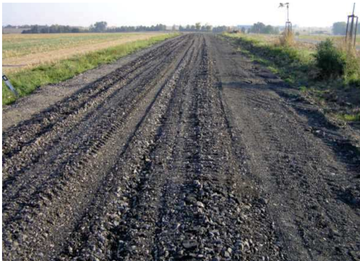
Rozfrézování asfaltových vrstev
