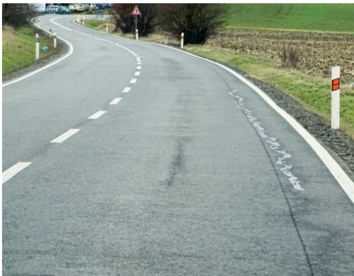
Koroze a poruchy na okraji vozovky
