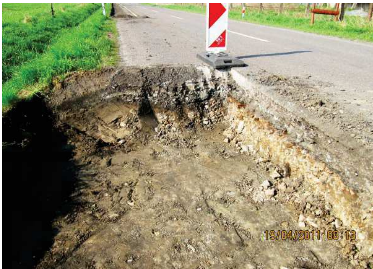
Urovnání a zhutnění parapláňe dole provedená úprava zemní pláně lomovým kamenem
