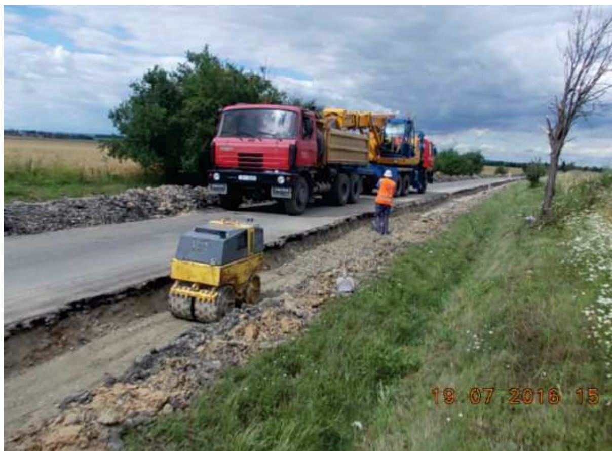
Sanace rýhy vhodným nenamrzavým materiálem v okraji silnice bez zajištění odvodnění
