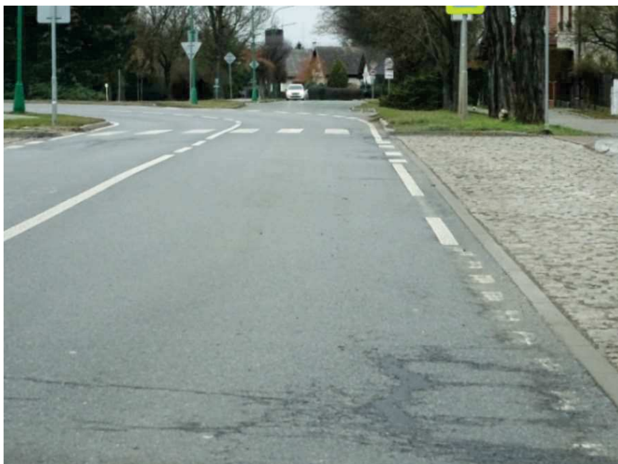
Lokální konstrukční poruchy a opravy
