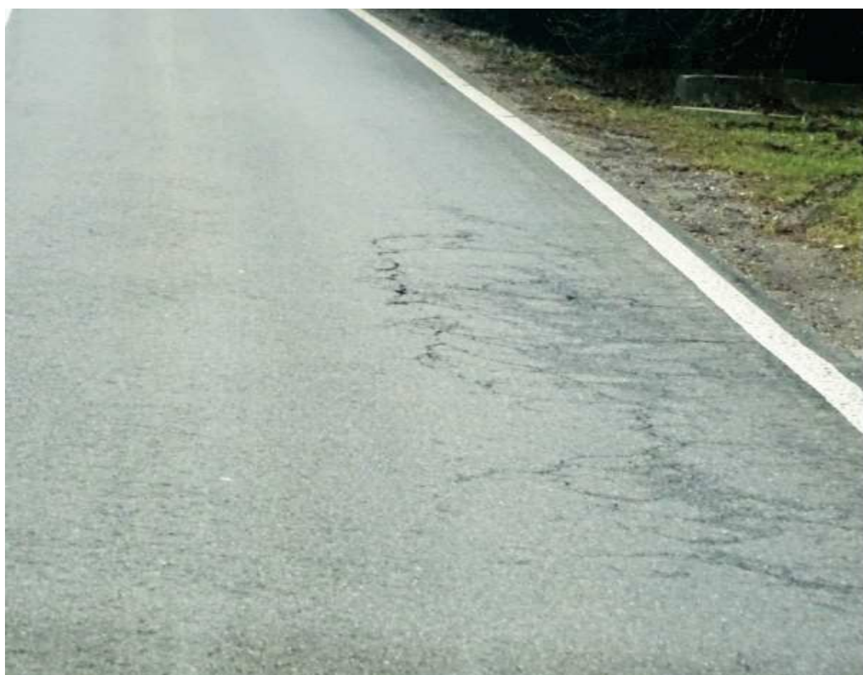
Mozaikové poruchy a síťové poruchy s poklesem okraje vozovky
