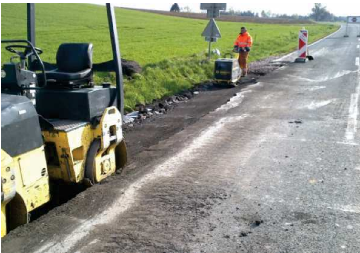
Urovnaná a zhutněná zemí pláň. dole po položení asfaltového recyklátu před odfrézováním starých asfaltových vrstev
