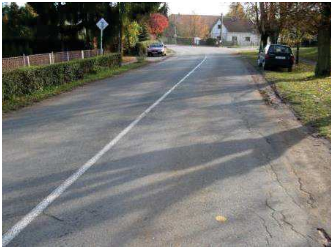
Fotografie 2, km 7,910 - Síťové trhliny na okraji vozovky po provedení vysprávký asfaltovou směsí
