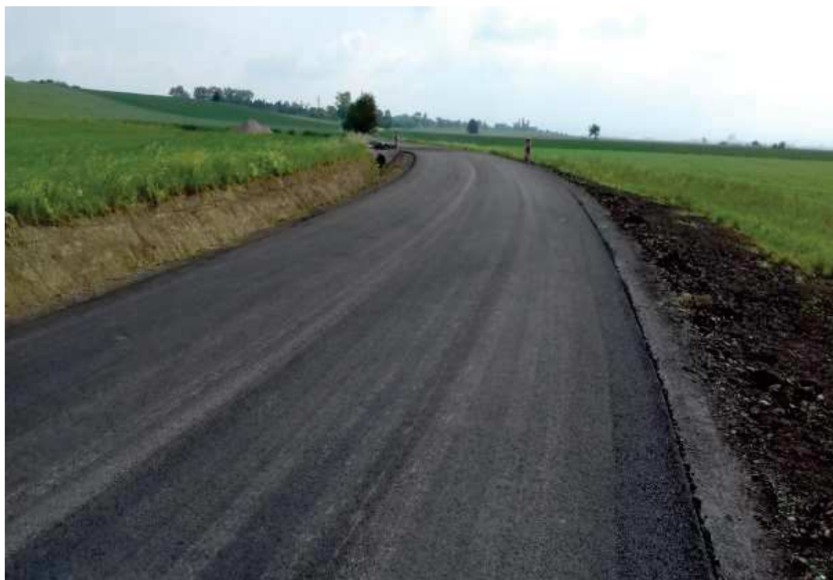
Položená ložní vrstva a dole i obrušná vrstva podélnou trhlinou
