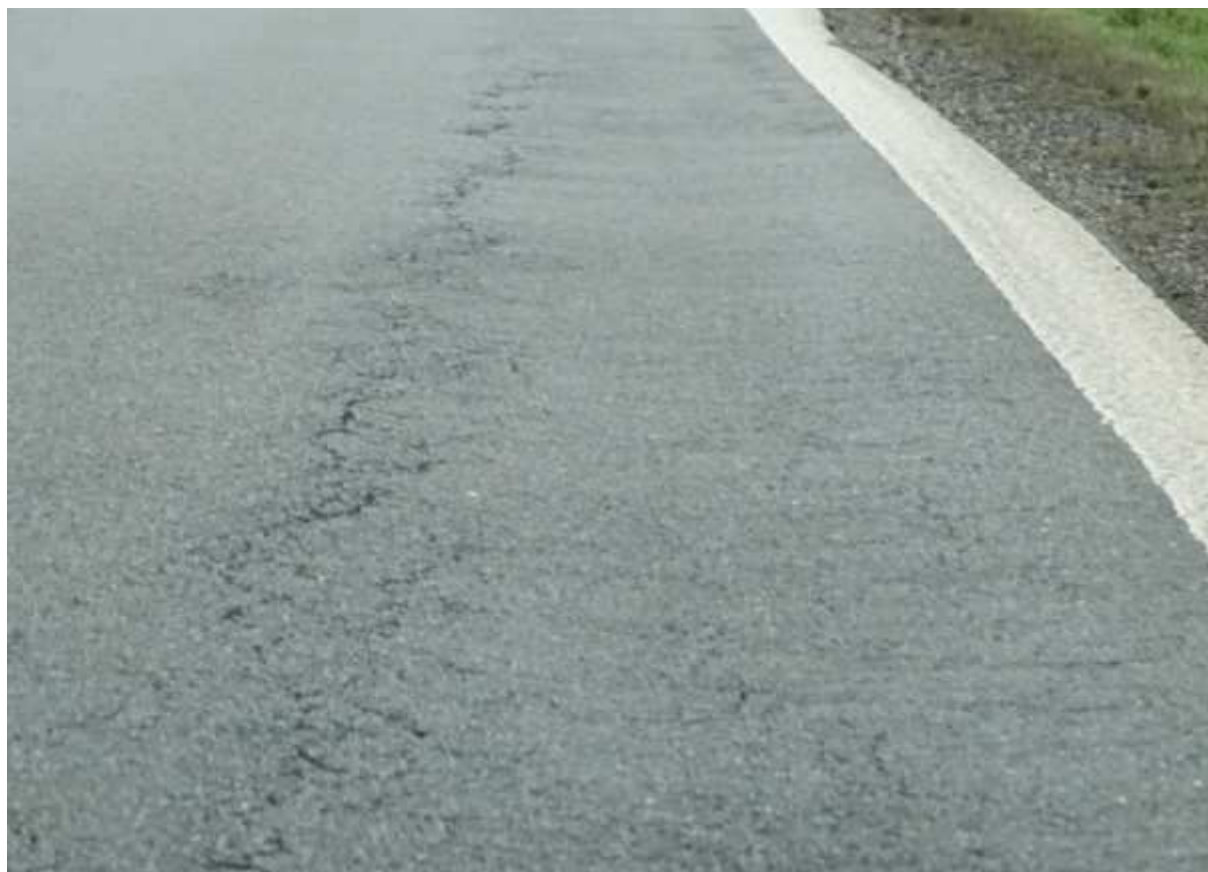
Lokální pokles okraje se sítovými trhlinami i v opravách vozovek
