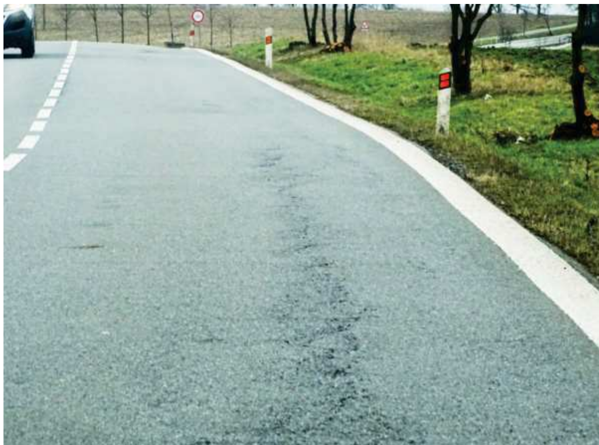
Úsek 1- Koroze povrchu poruchy okraje vozovky
