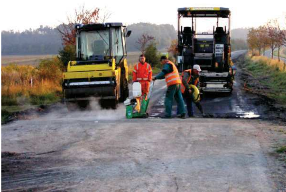
Pokládka podkladní asfaltové vrstvy
