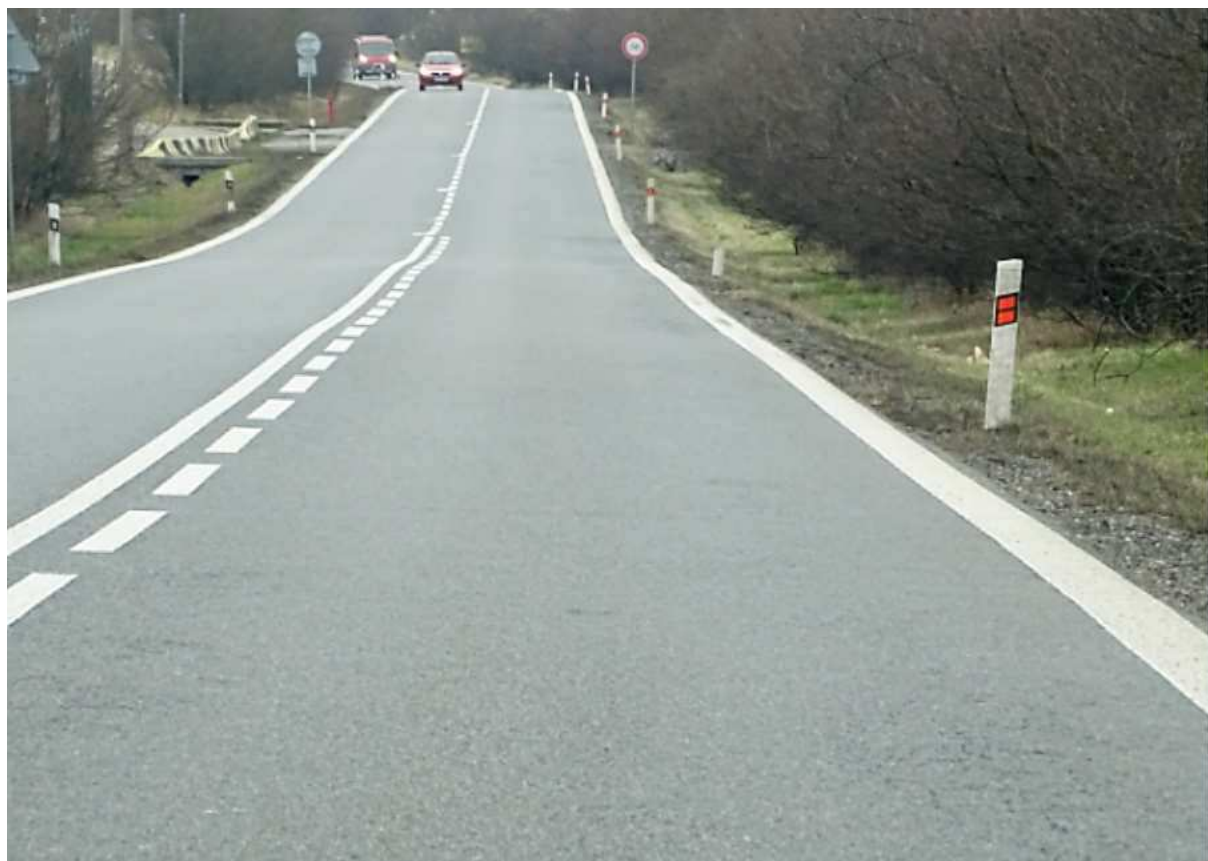
Úsek 1- Koroze povrchu poruchy okraje vozovky
