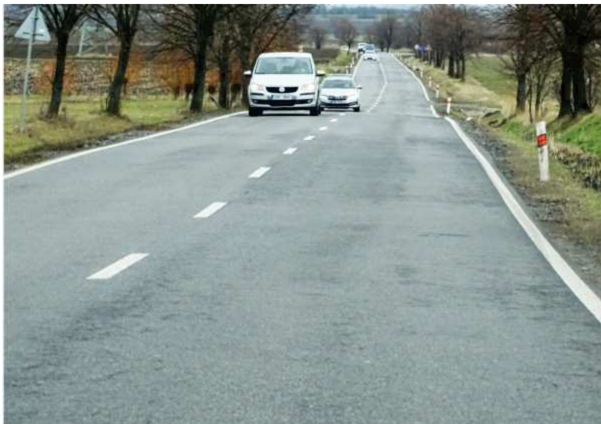
Koroze a poruchy trhlinami
