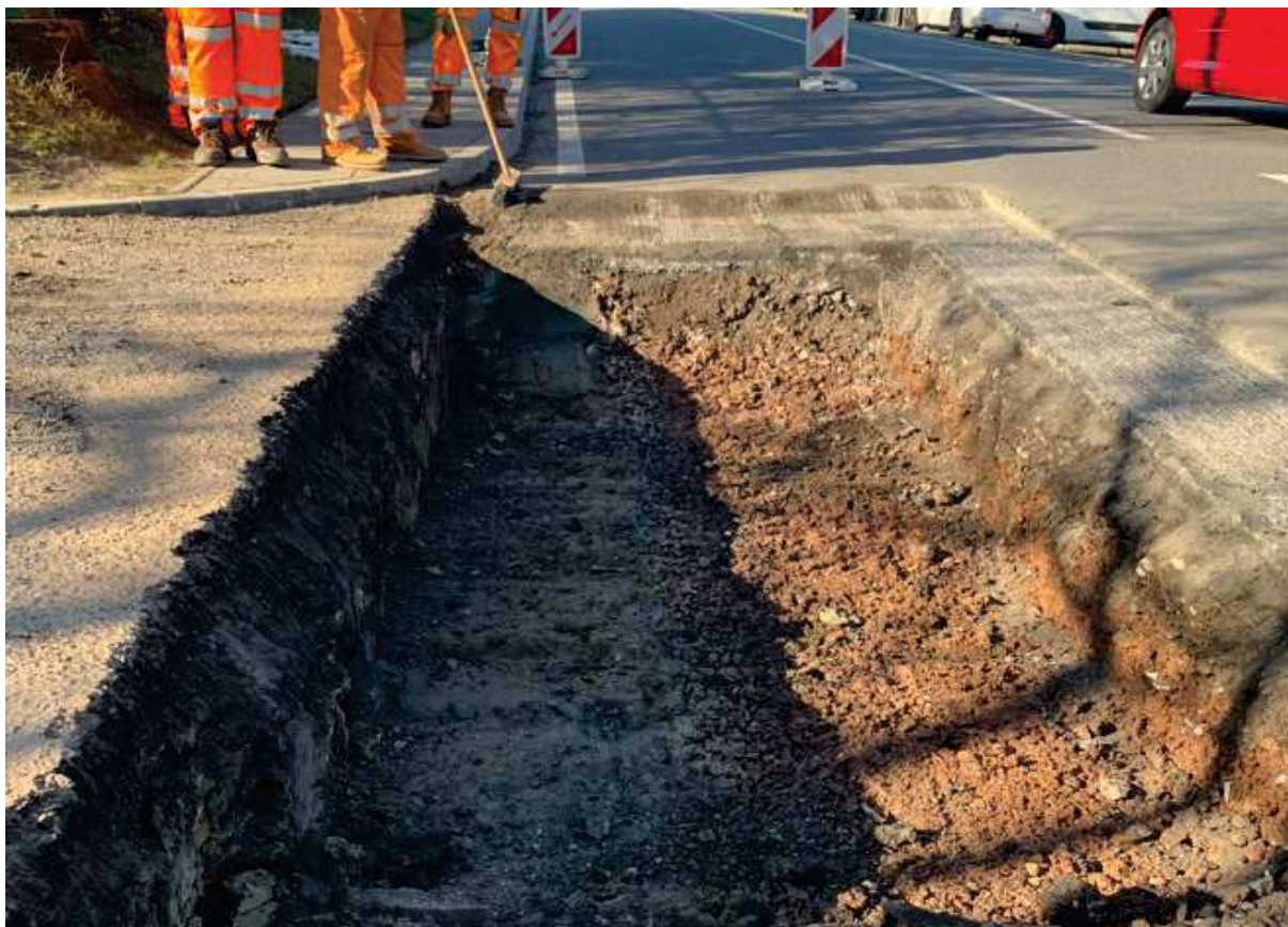
Podélná drenáž v průtahu obcí Černilov (schémata 3 až 6) měla být umístěna vpravo od km 7,72 až 7,938 a vlevo od km 7,790 až 7,938.
