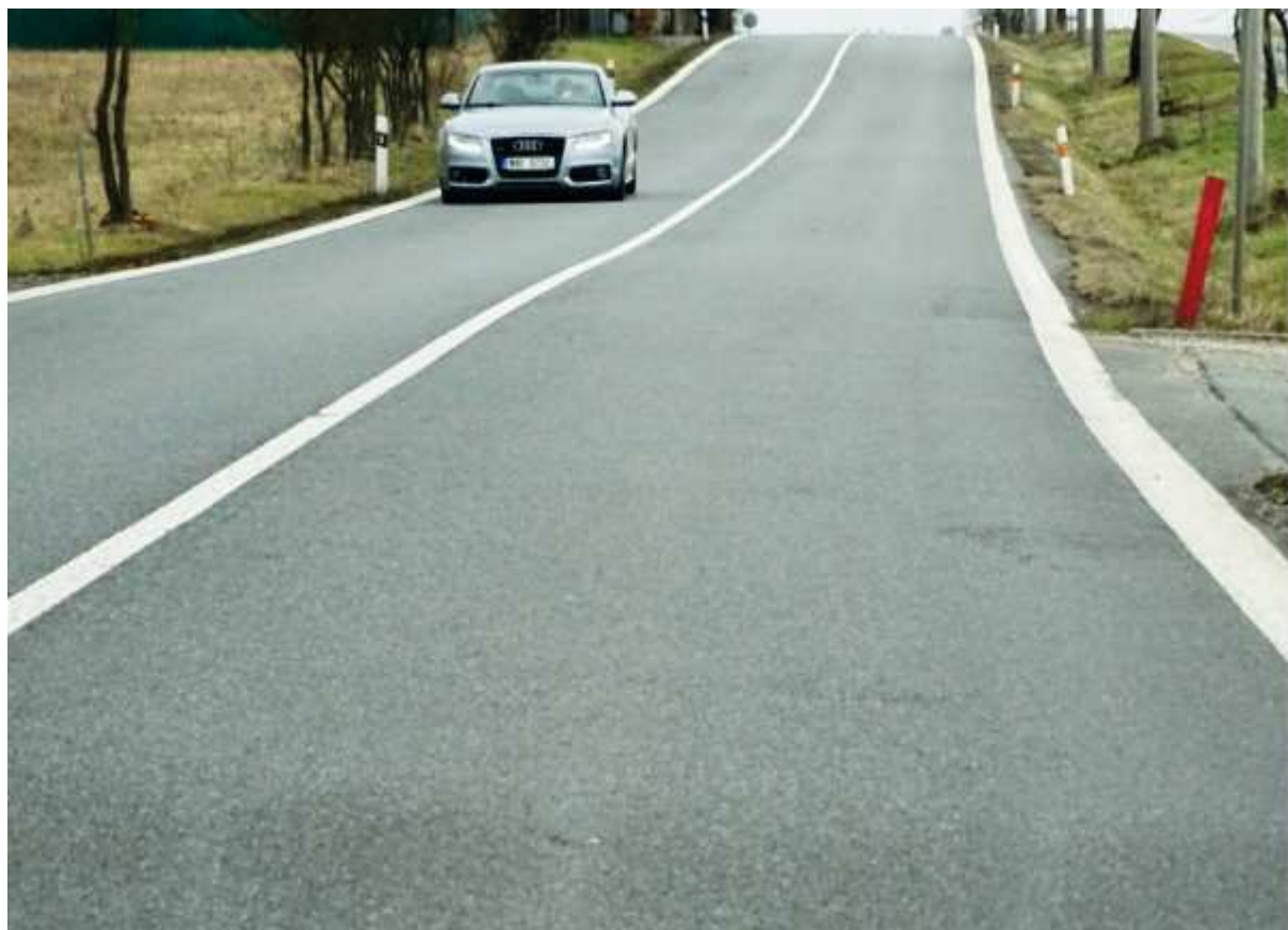
Poruchy v jízdních stopách, vážnější poruchy při okrajích vozovky
