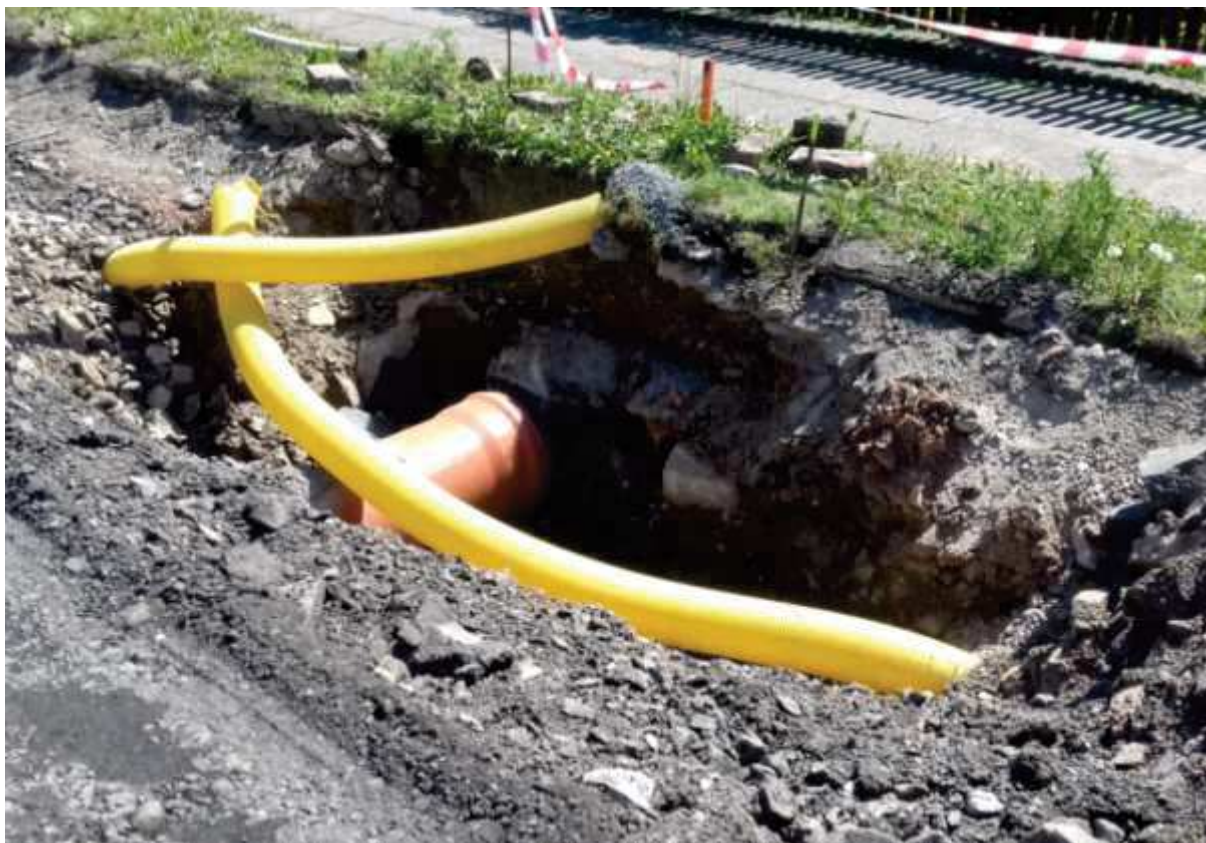
Propustek a položené drenážní trubky pro zabudování do kanalizační šachty.
