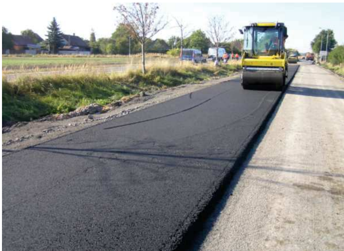
Pokládka podkladní asfaltové vrstvy
