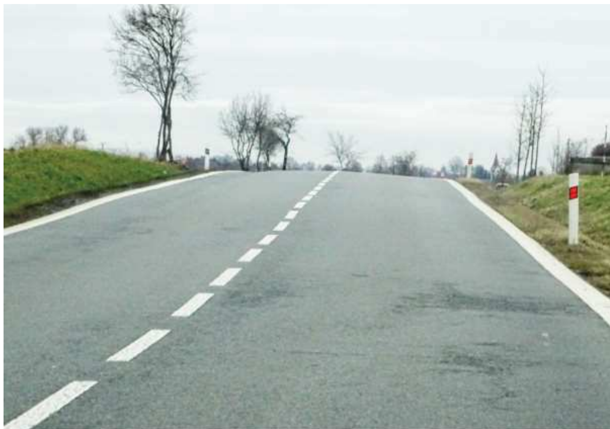
Koroze povrchu a nerovnosti vozovky s trhlinami
