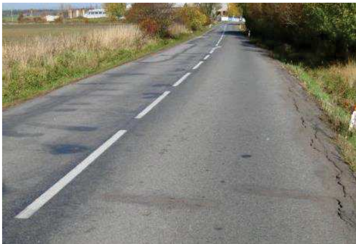
Fotografie 5, km 10,710 - Vpravo olamování okraje vozovky, vlevo vysprávký krátkých příčných a mozaikových trhlín.
