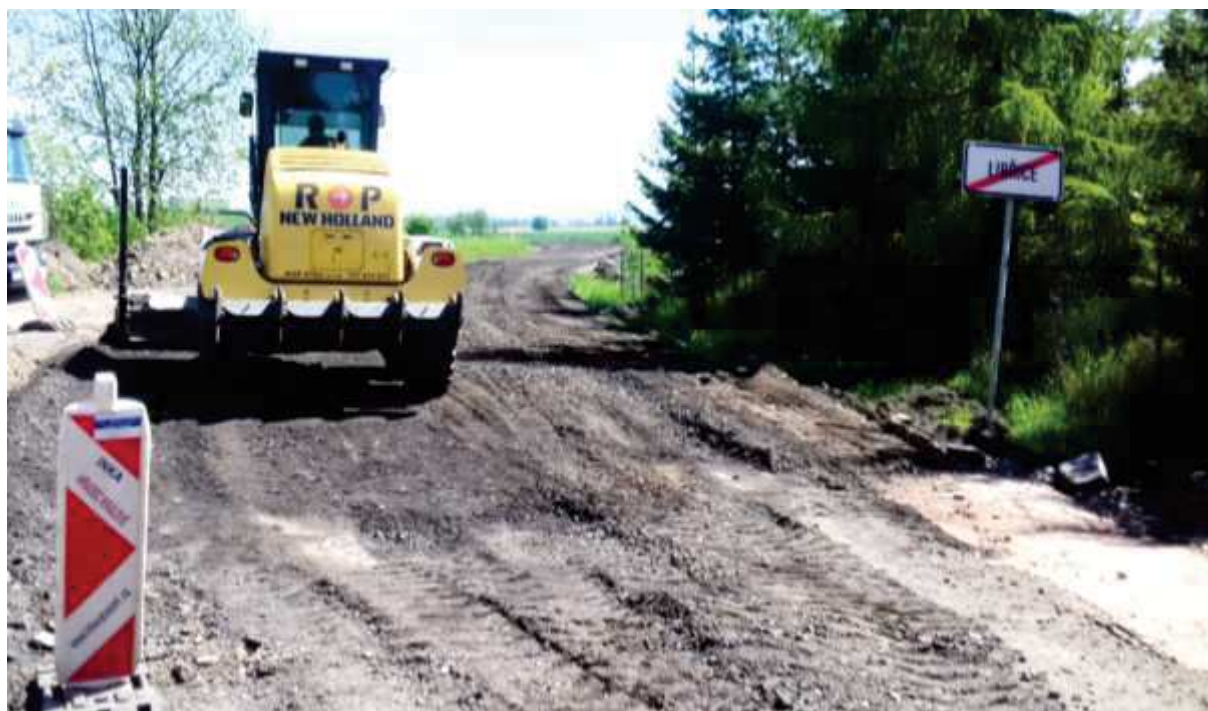
Dokumentování postupu opravy mimo obec, příprava k recyklaci a položení ložní vrstvy
