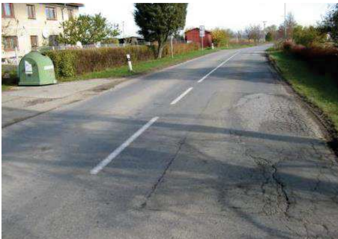
Fotografie 3, km 8,420 - Síťové trhliny a plošné deformace ve vysprávce (prolomení vozovky)
