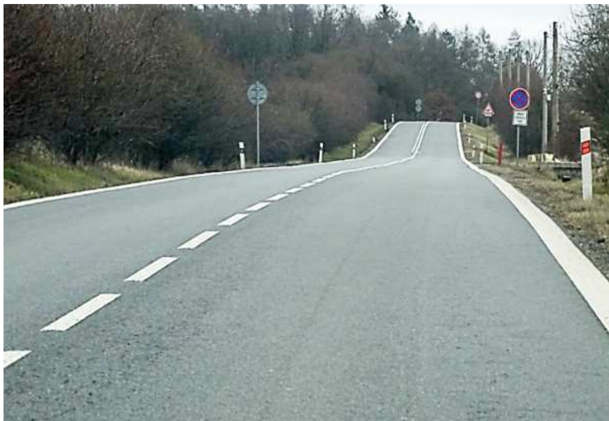
Poruchy v jízdních stopách, vážnější poruchy při okrajích vozovky
