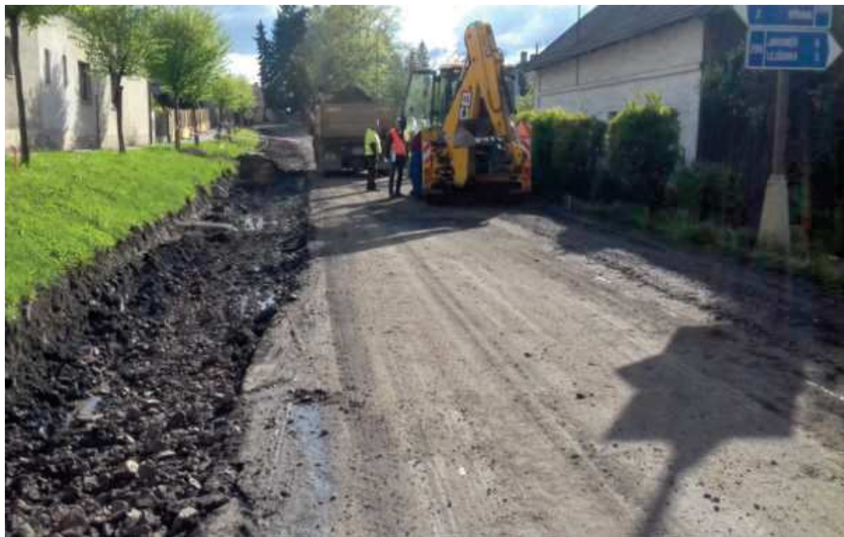
Odfrézované asfaltové vrstvy a odebrané podkladní vrstvy z vozovky, dole je rýhy a provádění kanalizace
