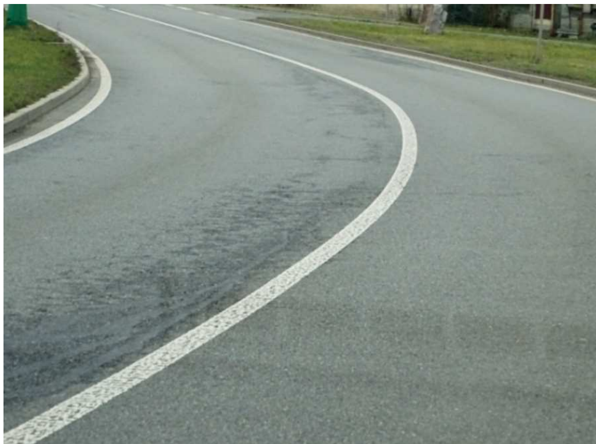
Konstrukční poruchy a lokální opravy
