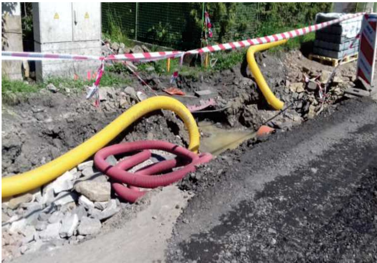
Propustek a položené drenážní trubky pro zabudování do kanalizační šachty.
