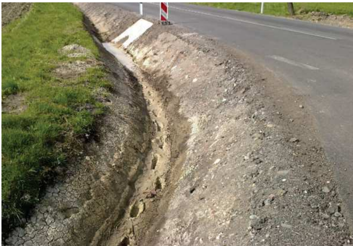
Detail propustku a příkopu s usazenou tekutou zeminou v příkopu, fotografie je dne 25.04.2017. V příloze 1 jsou detaily provedení propustku včetně dokumentace DPS a RDS.
