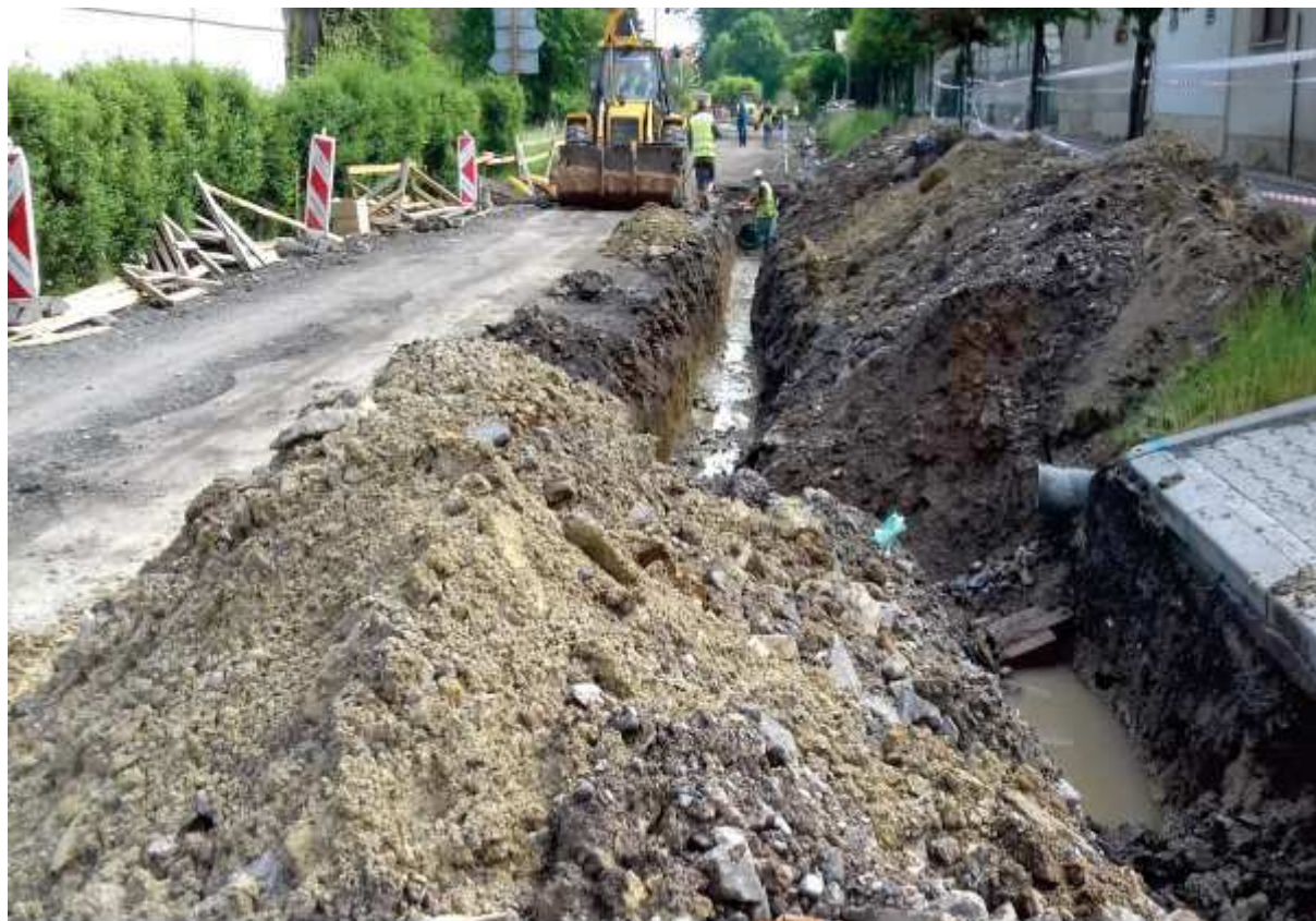
Odfrézované asfaltové vrstvy a odebrané podkladní vrstvy z vozovky, dole je rýhy a provádění kanalizace
