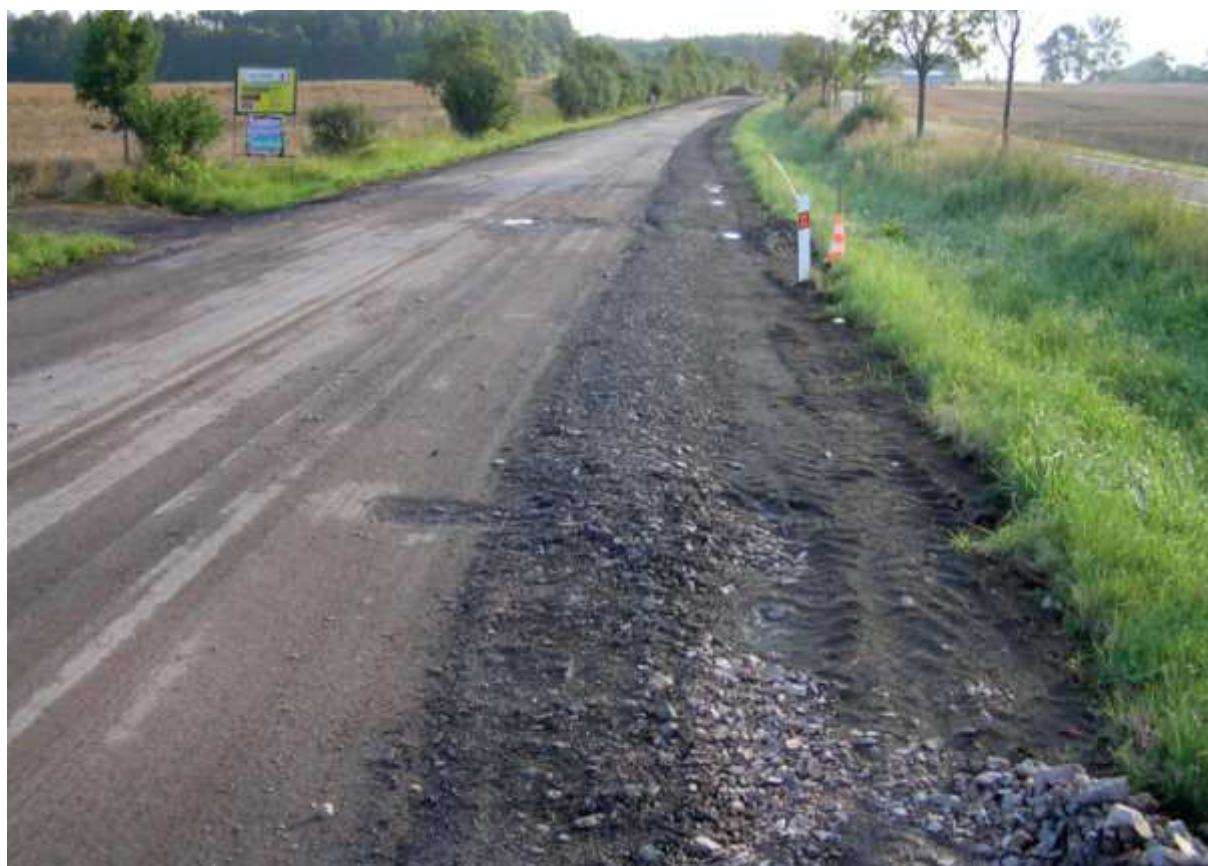
Výstavba vozovky v rýze v okraji silnice horní vrstva recyklátu
