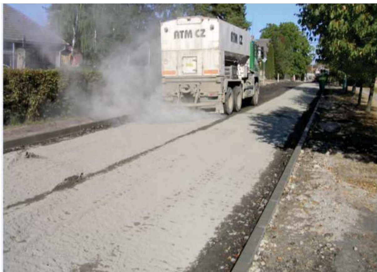
Recyklace podkladu, dole rozprostírání cementu
