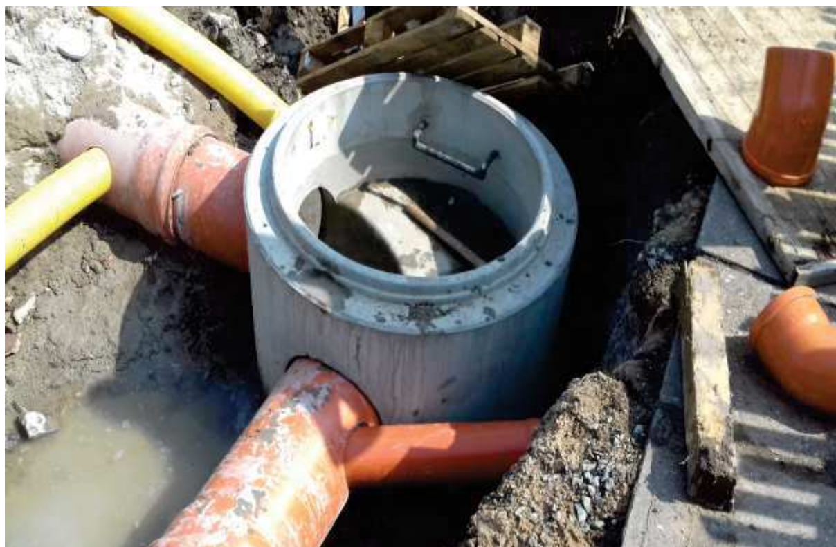
Kanalizační šachta se zaústěním drenáže, dole již položené obručníky
