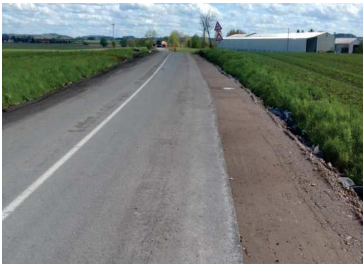
Dokončení okraje před frézováním asfaltových vrstev
