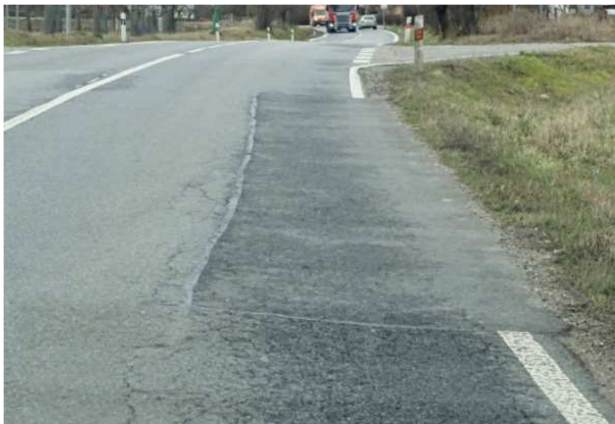
Lokální pokles okraje se sítovými trhlinami i v opravách vozovek
