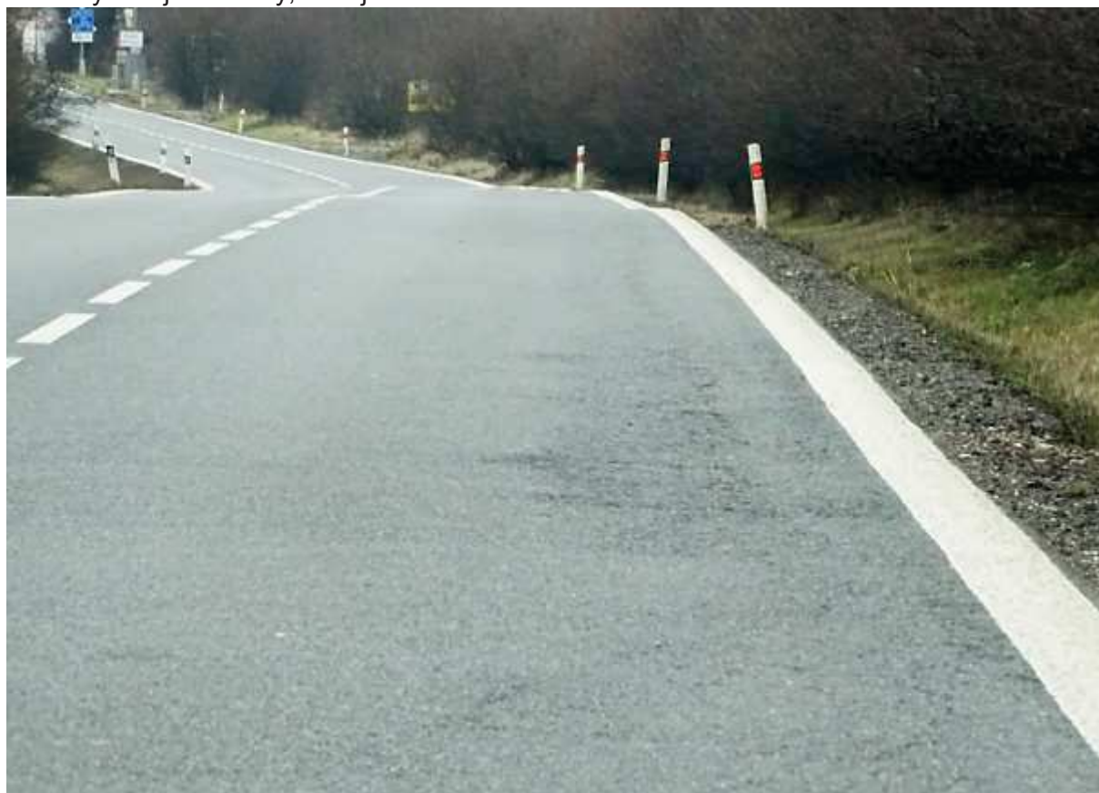
Poruchy okraje vozovky, dole je začátek úseku 1
