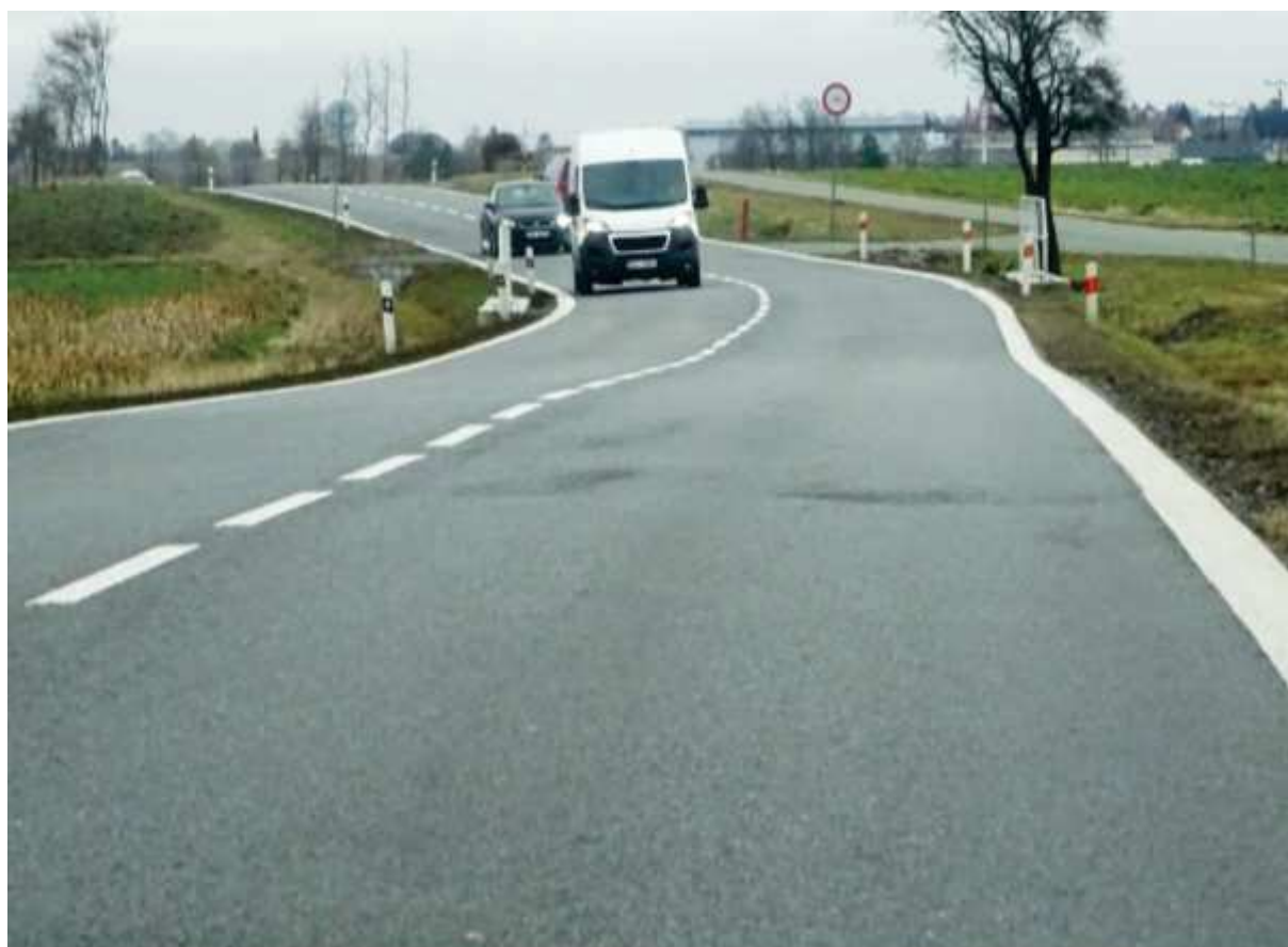
Koroze povrchu a nerovnosti vozovky s trhlinami
