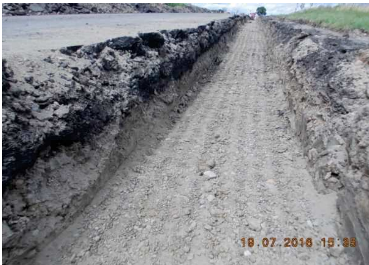
Sanace rýhy vhodným nenamrzavým materiálem v okraji silnice bez zajištění odvodnění
