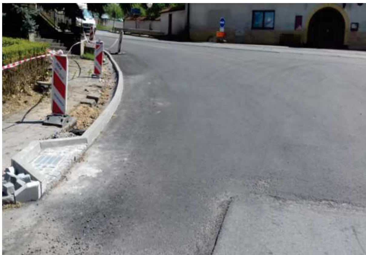
Odfrézované asfaltové vrstvy v křižovatce, dole položená ložní vrstva
