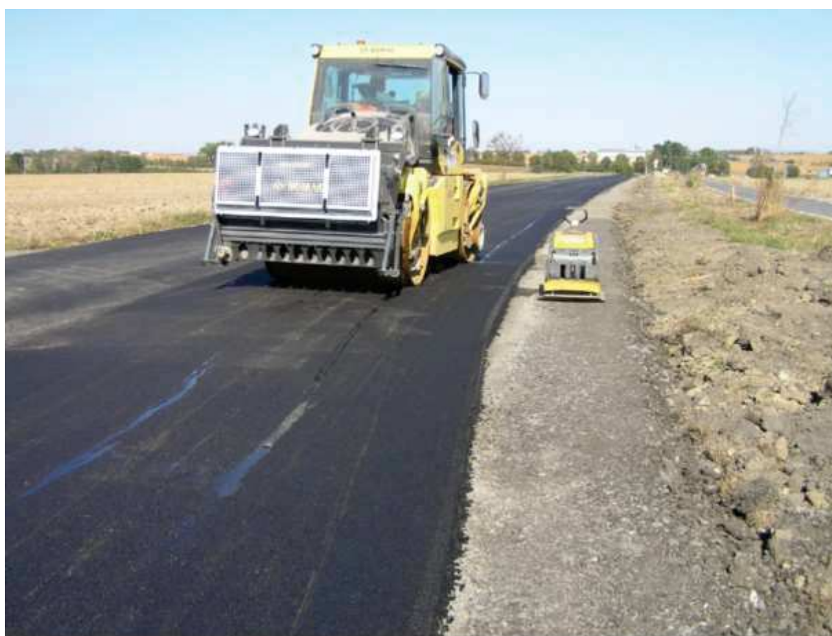
Dokončená vozovka před provedením nestmelené krajnice a příkopů
