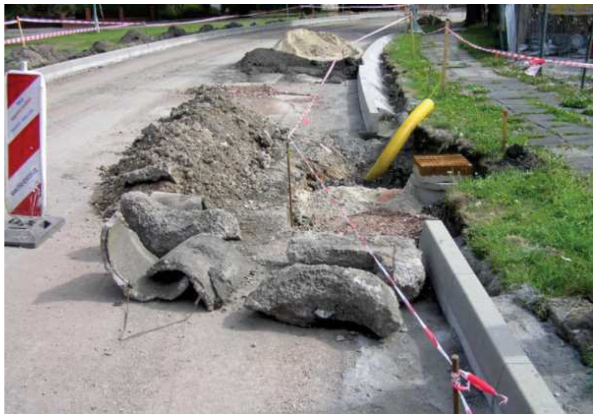
Provedená recyklace podkladu a dokončovací práce
