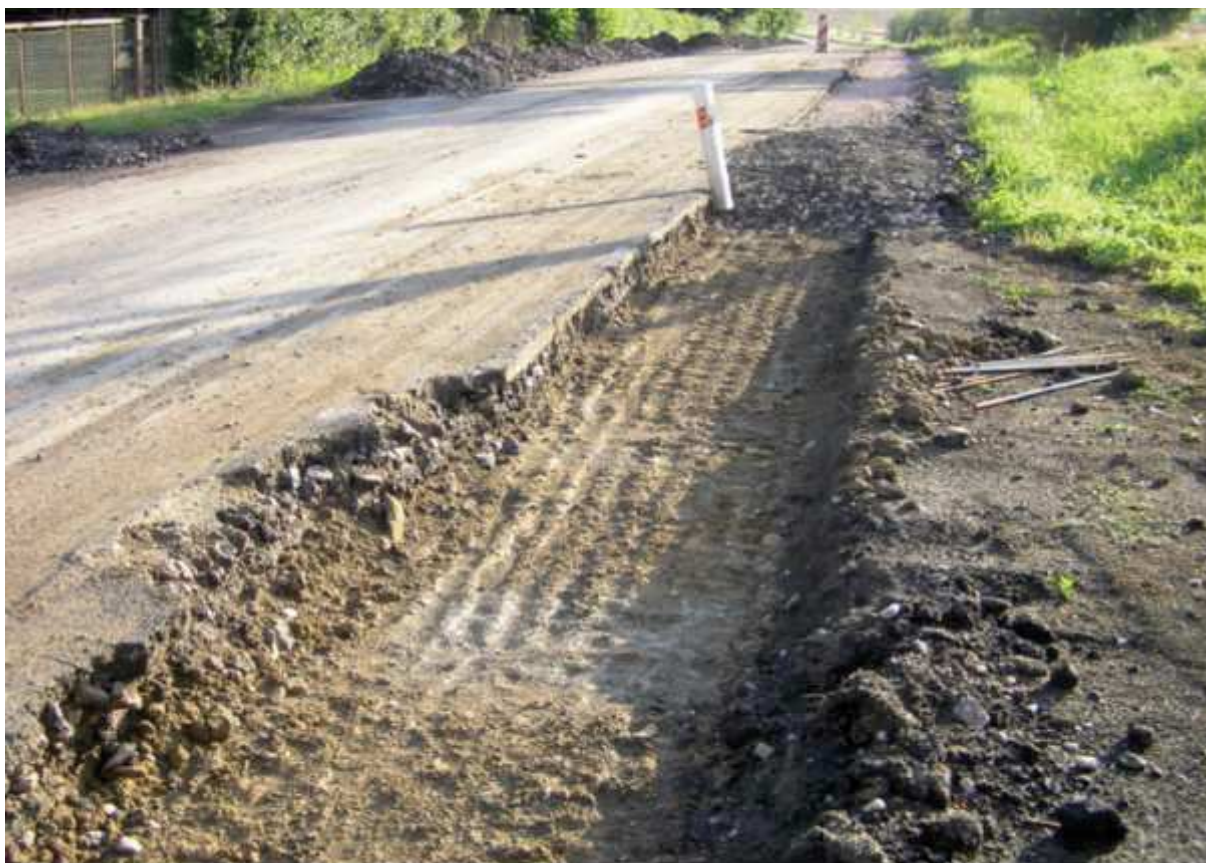
Úprava nevhodné zeminy na hrázce pojivem GEOSOL C50 a její zabudování do rýhy
