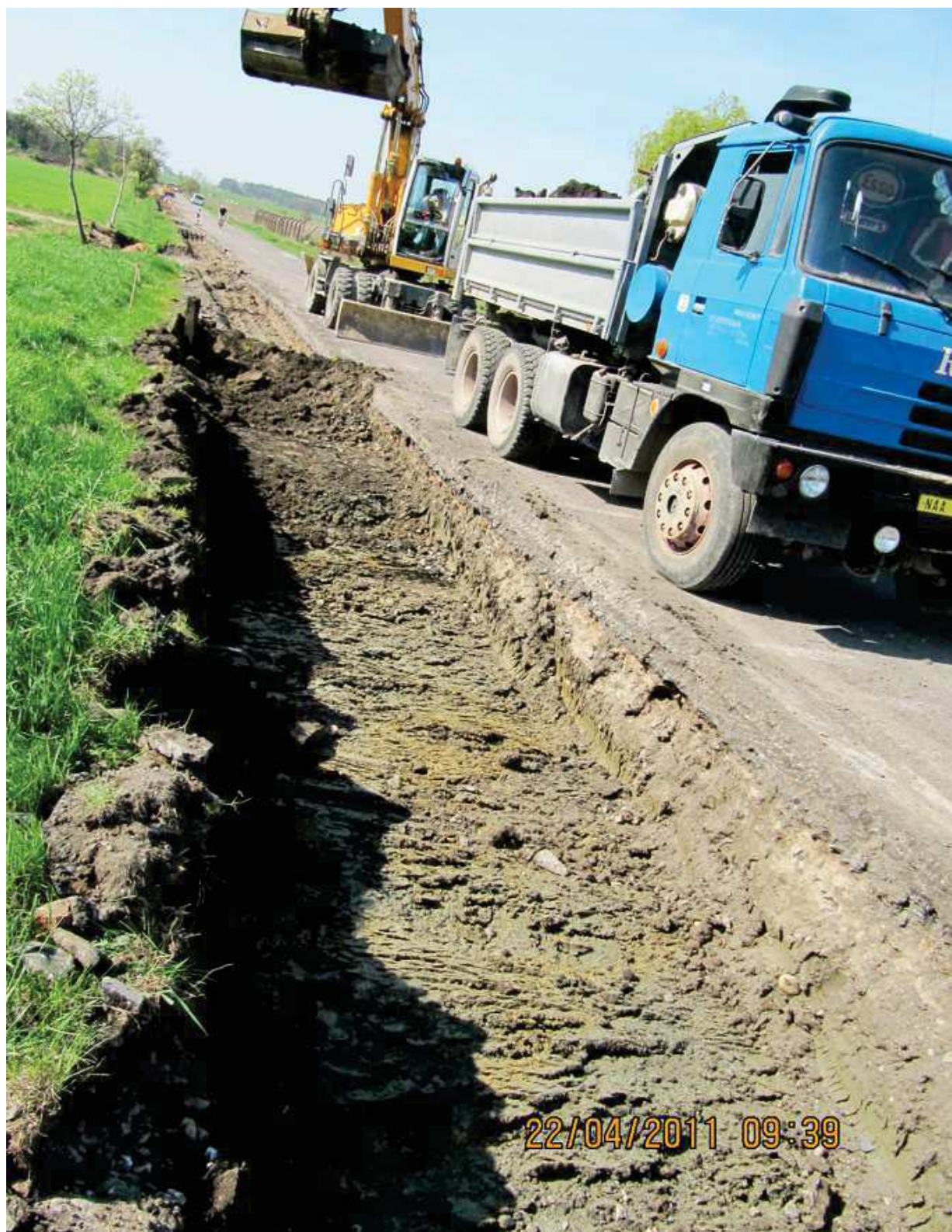
Výkop okraje vozovky až ke hraně příkopu
