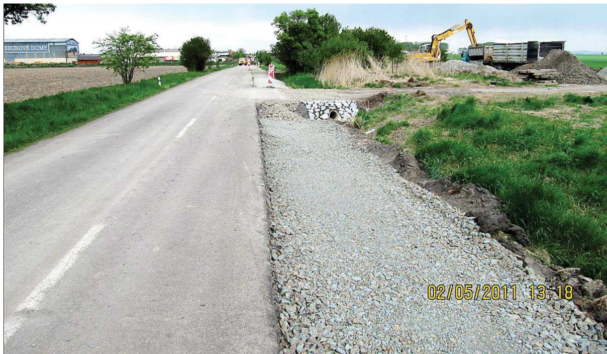
Obrázek 15 - Aktivní zóna stavby z roku 2011 ze štěrkodrti je provedena na šířku až ke hraně příkopu
