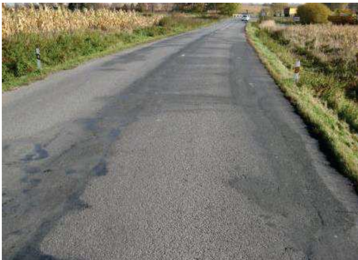
Fotografie 1, km 5,710 - Velkoplošné vysprávkování tryskovou metodou (tj. postřik asfaltem a posyp drtí velikosti 4/8 mm) podél okrajů vozovky a trhlin příčných, nepravidelných a mozaikových
