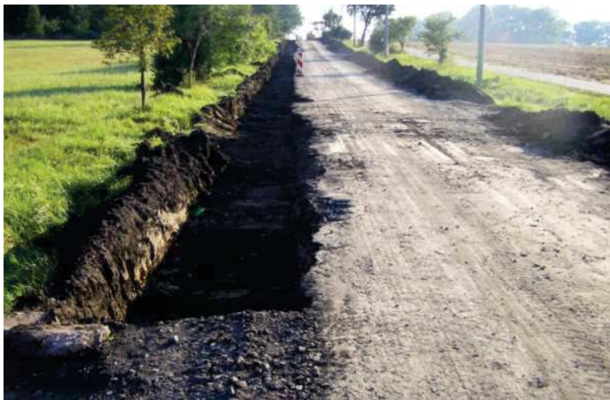
Rýha pro provedení rekonstrukce vozovky okrajů silnice bez zajištění odvodnění podloží
