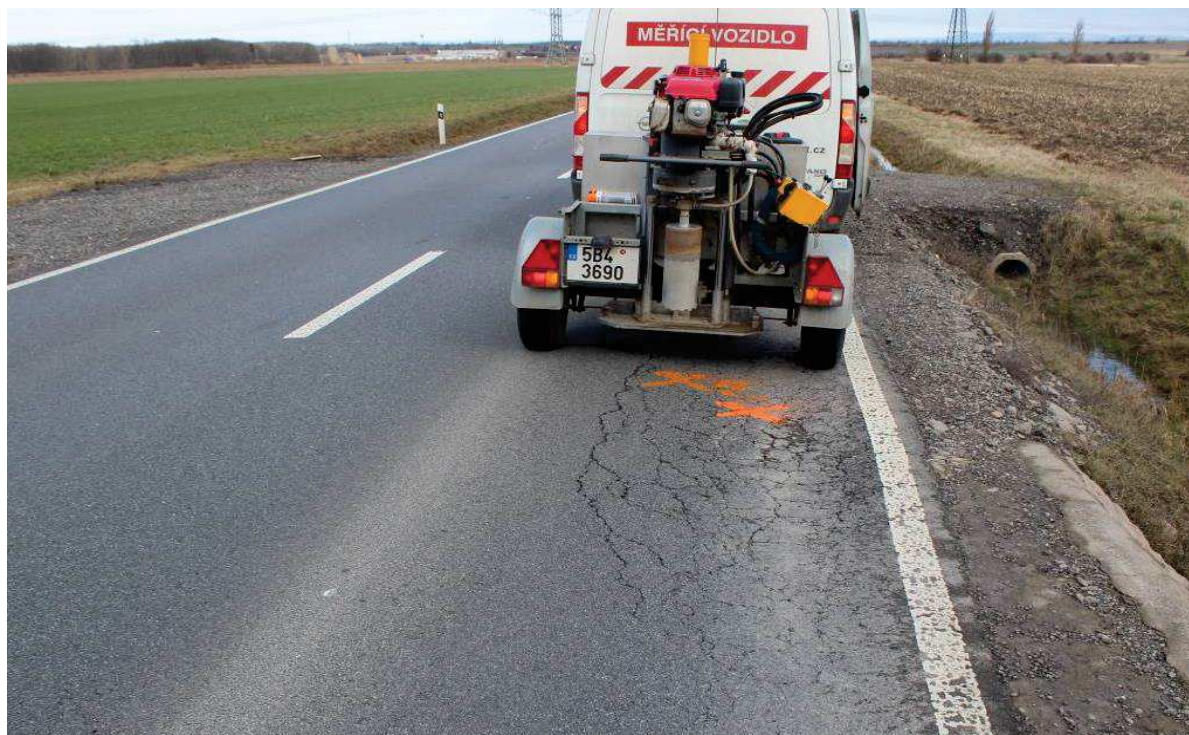
Obrázek 19 – Výrazná lokální porucha se síťovými trhlinami s poklesem vozovky až 50 mm včetně deformací násypového tělesa a příkopu, km 9,315
