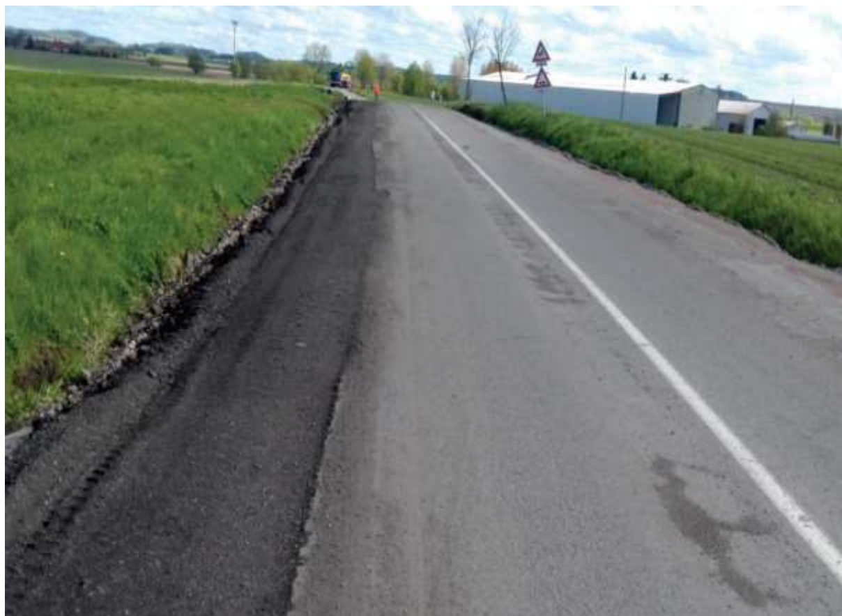
Dokončení okraje před frézováním asfaltových vrstev
