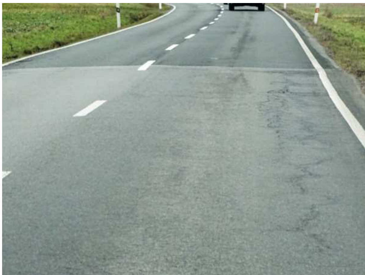
Koroze a poruchy okrajů vozovky, konec úseku 4
