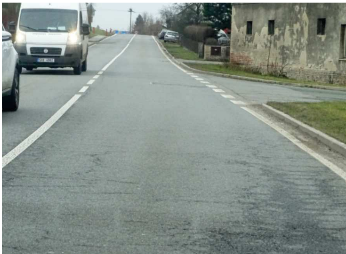
Konstrukční poruchy a lokální opravy
