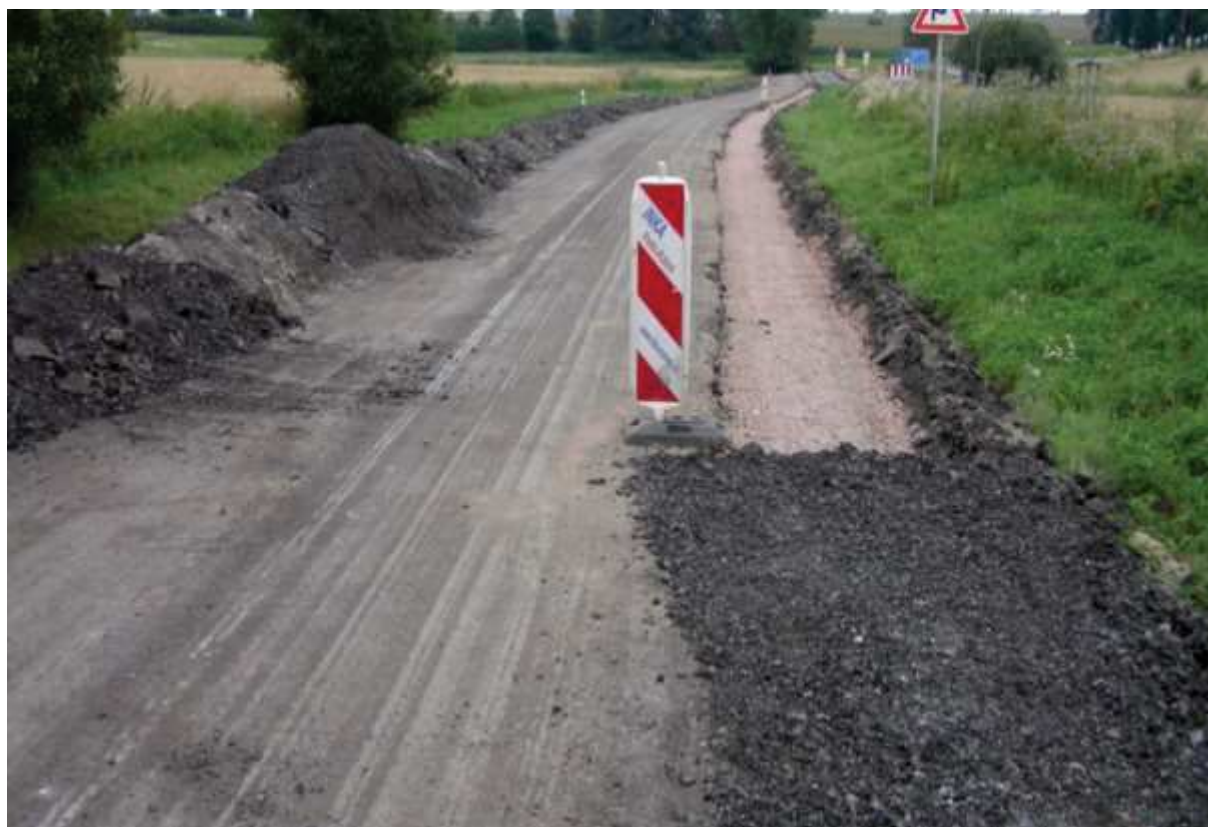
Výstavba vozovky v rýze v okraji silnice horní vrstva recyklátu
