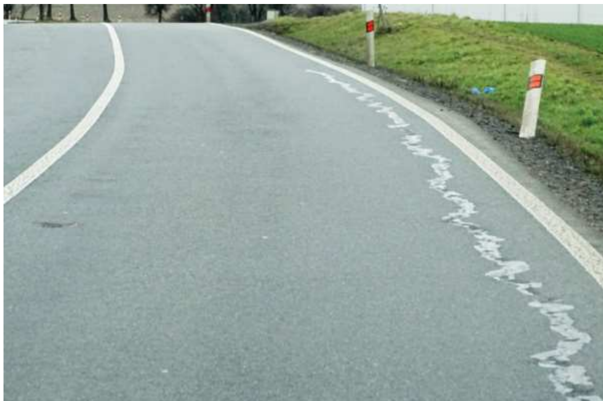
Trhlina na okraji, úsek 3 za koncem obce Libřice, dole zpětný pohled na poruchy jako na stranách 12 až 14
