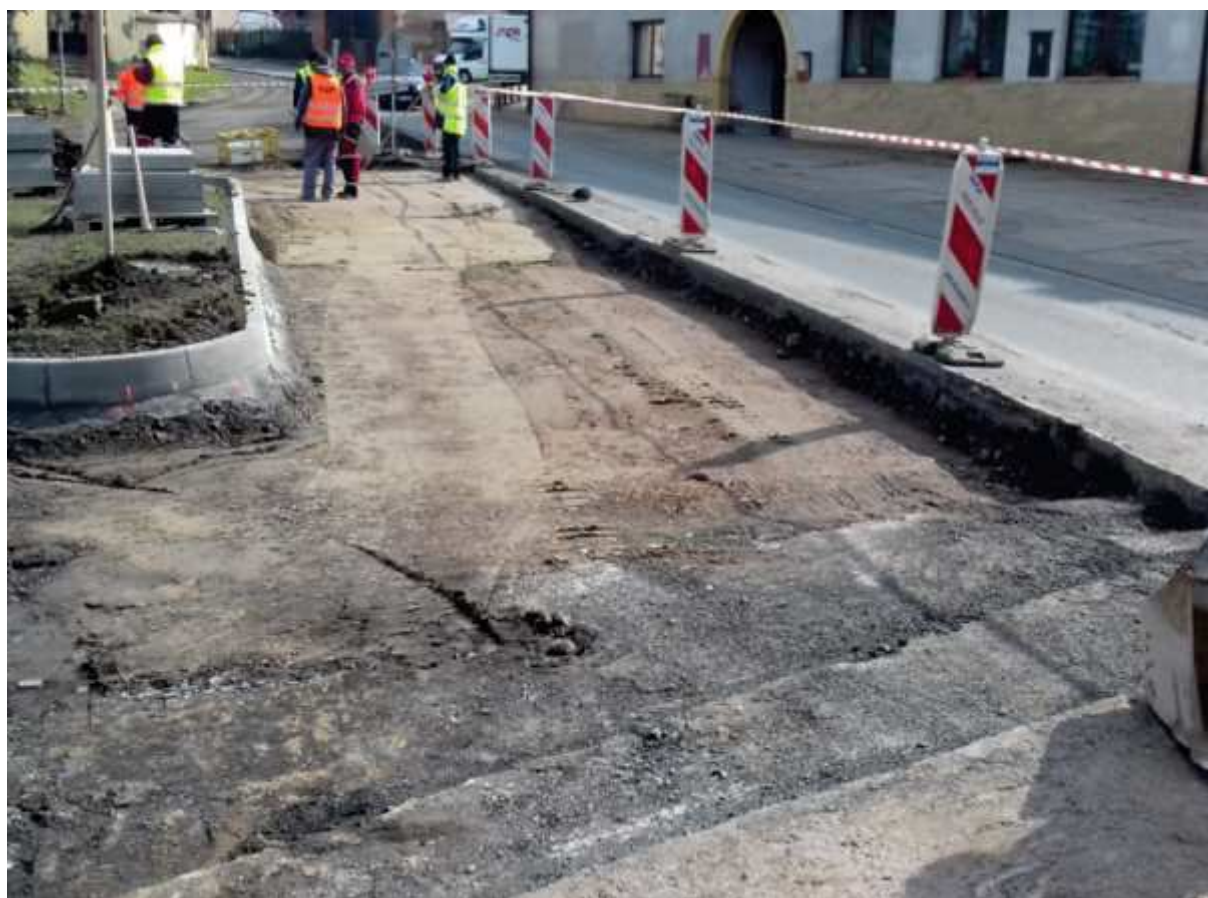
Příprava pro provedení podkladu recyklací, dole křižovatka s II/299, provádění podkladu z cementem stmeleného kameniva před pokládkou asfaltových vrstev
