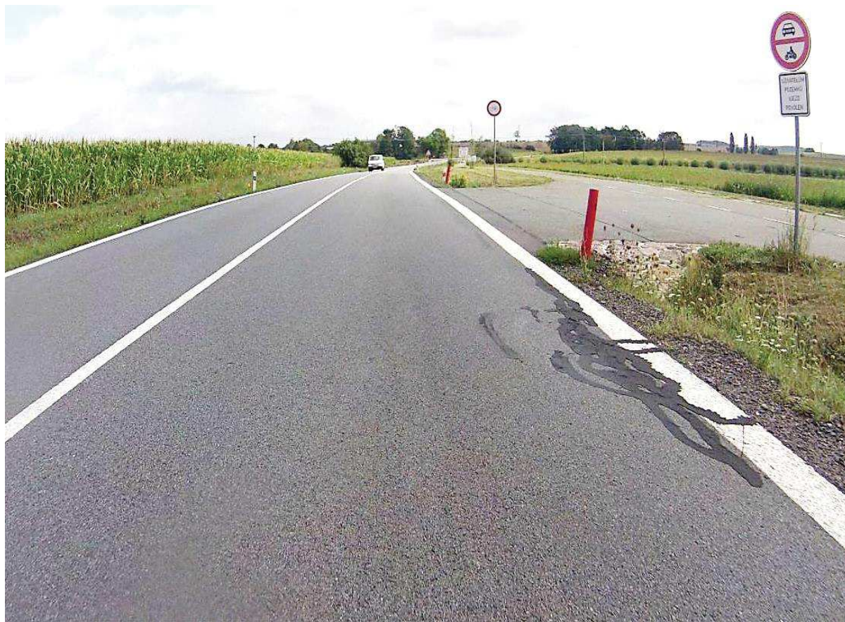
Obrázek 18 – Výrazná lokální porucha se síťovými trhlinami poklesem vozovky a deformací násypového tělesa, stav v srpnu 2019 (necelé 3 roky po dokončení stavby), km 5,888
