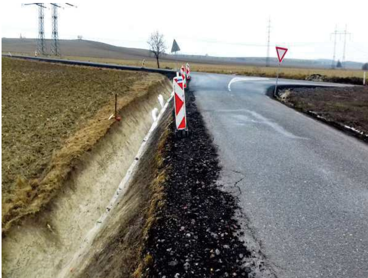
Pohled na výtok z propustku, příkop zaplněn stojící vodou, dole protažení příkopu v odbočce na obec Výrava s klesající hladinou vody (vadné spádování příkopu).
