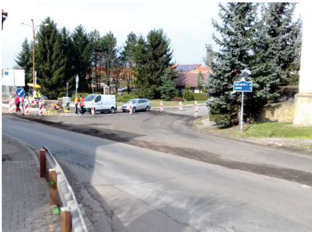
Odfrézované asfaltové vrstvy v křižovatce, dole položená ložní vrstva
