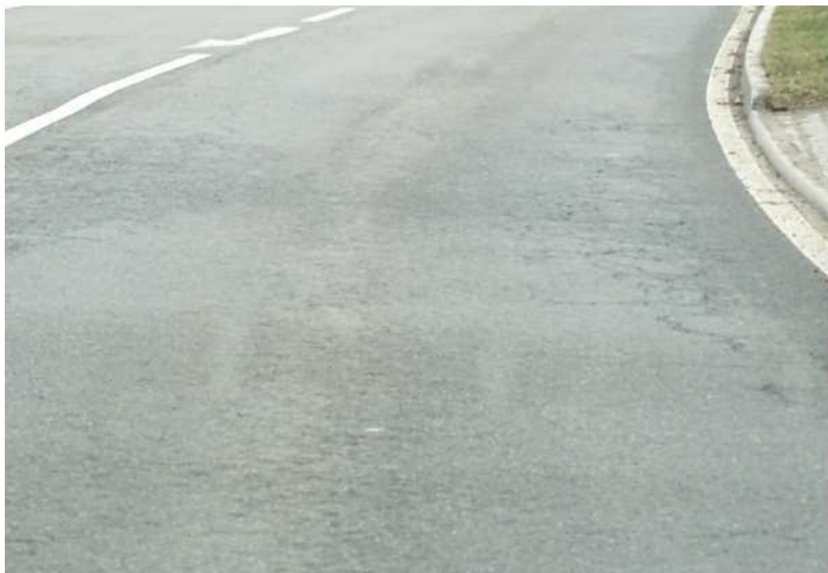
Mozaikové poruchy a síťové poruchy s poklesem okraje vozovky
