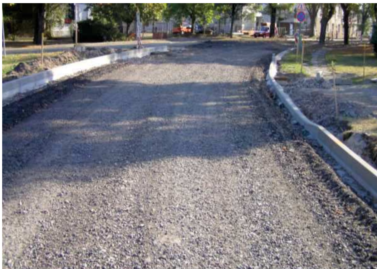
Příprava pro recyklaci podkladu rozfrézováním asfaltových vrstev a přidáním recyklátu nad rýhy v okraji vozovky
