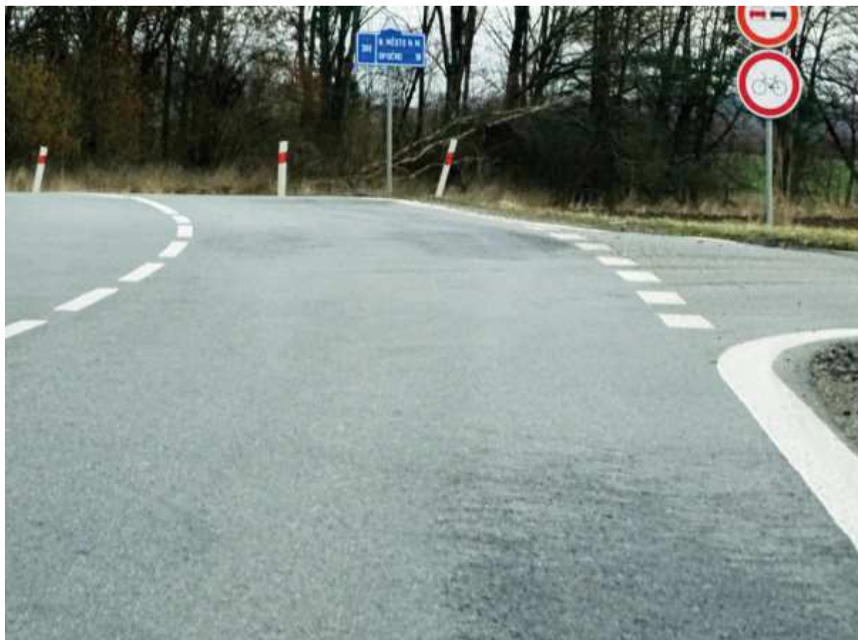
Koroze povrchu a nerovnosti vozovky s trhlinami konec úseku 1, následuje oprava z rok 2011
