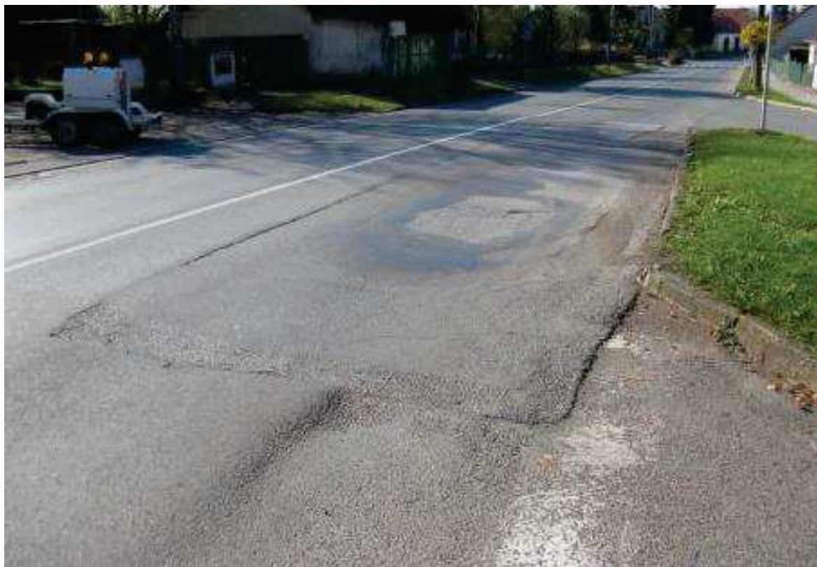
Fotografie 6, km 12,060 – Vysprávka asfaltovou směsí, opět se vyskytující síťové trhliny (prolomení vozovky).
