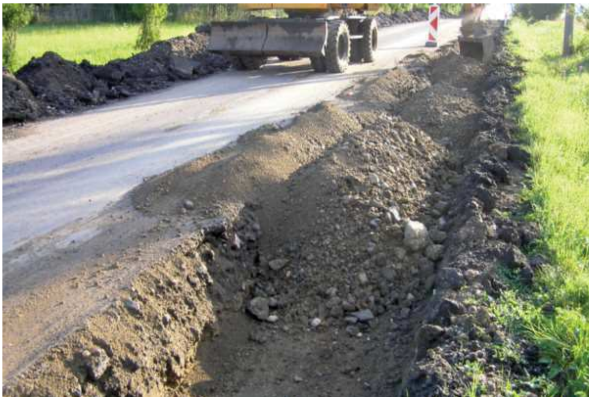
Výstavba vozovky v rýze v okraji silnice bez zajištění odvodnění, dole poslední vrstva v rýze neznámého původu
