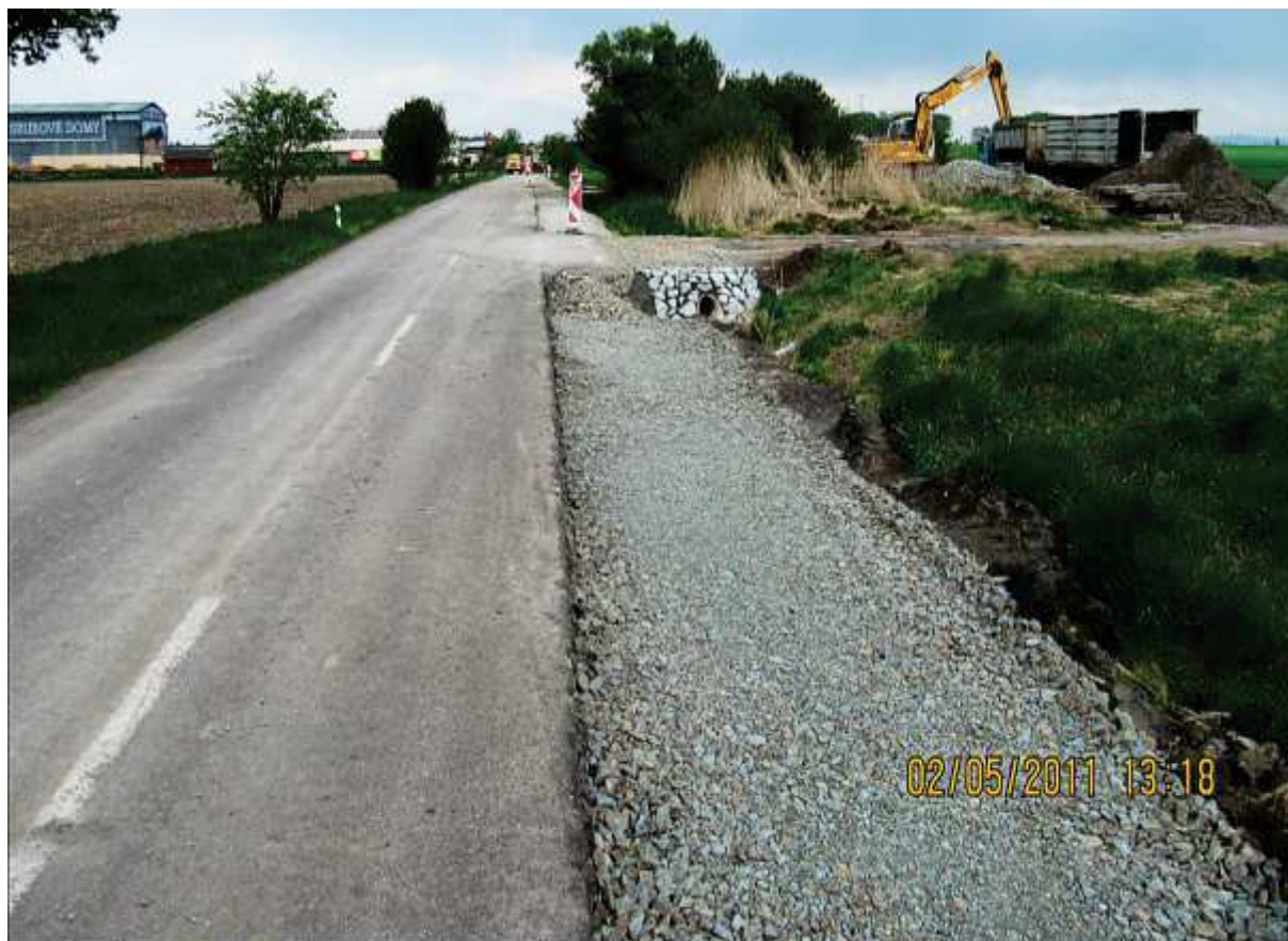
Urovnaná a zhutněná zemní pláň až po hranu příkopu
