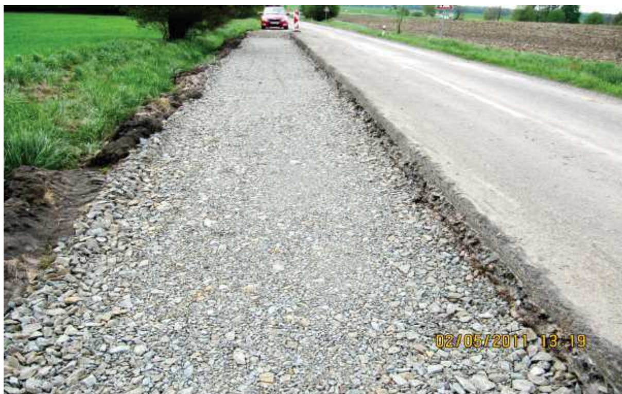
Provedená úprava zemní pláně lomovým kamenem
