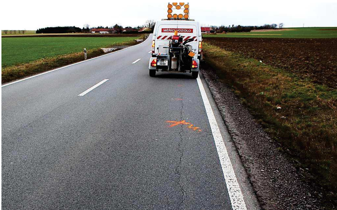
Obrázek 21 – Porucha podélnou trhlinou v krajní jízdní stopě vozidel, charakteristika rozdílných konstrukcí vozovek, km 12,980
