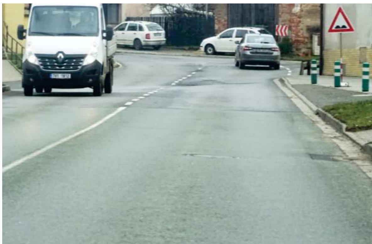
Konec úseku 3. Poruchy únosnosti, prolomení vozovky
