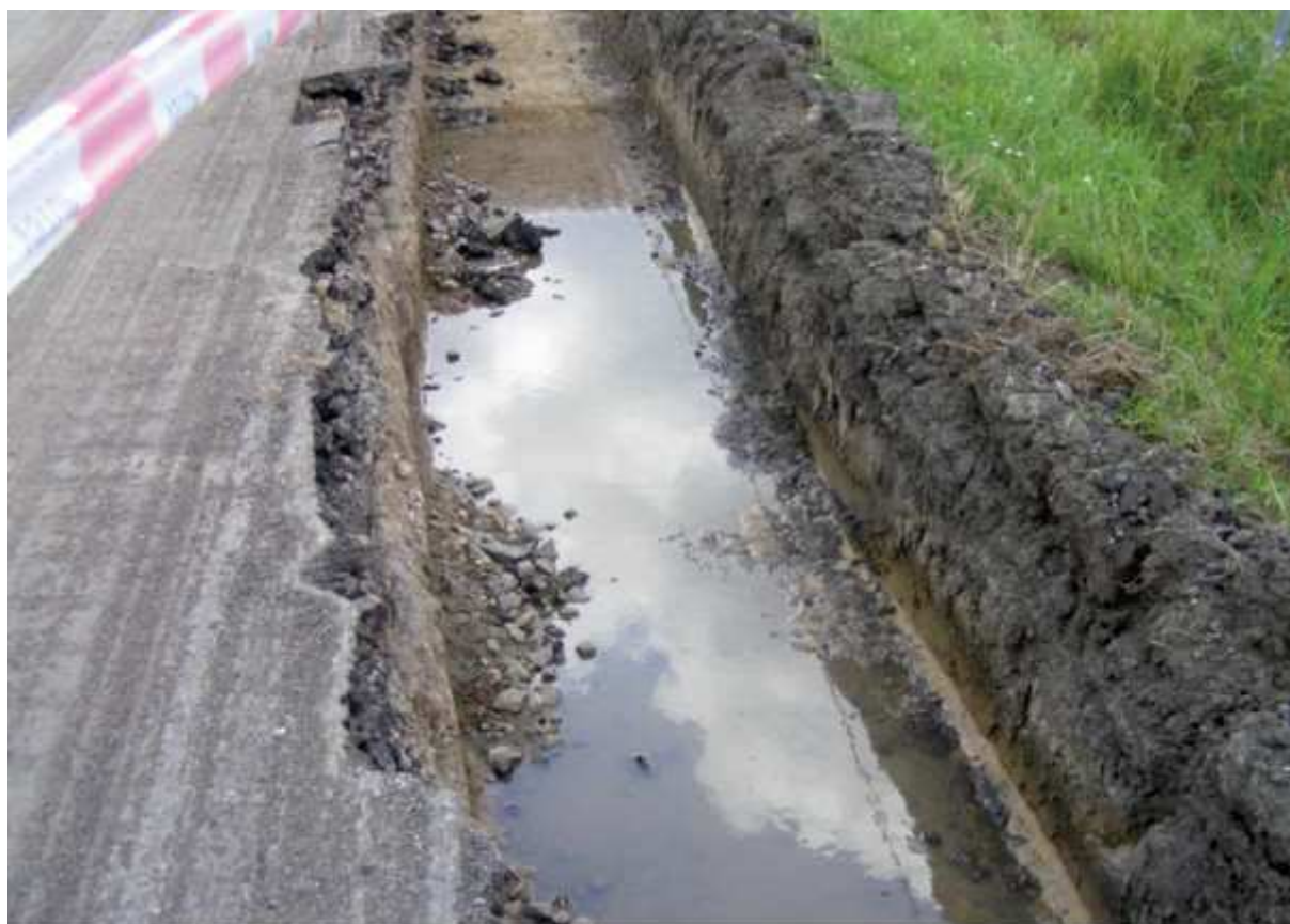
Rýha pro provedení rekonstrukce vozovky okrajů silnice bez zajištění odvodnění podloží, výskyt povrchové vody jak v podloží, tak propustné sanační vrstvě
