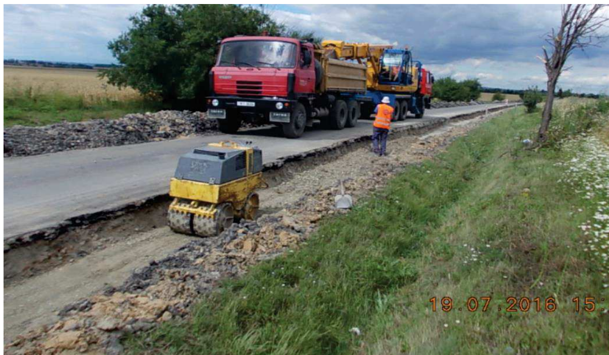
Obrázek 16 - Aktivní zóna stavby z roku 2016 je úzká mezi výkopem a příkopem zůstává původní zemina, řešení nemůže zajistit odtok vody z aktivní zóny.
